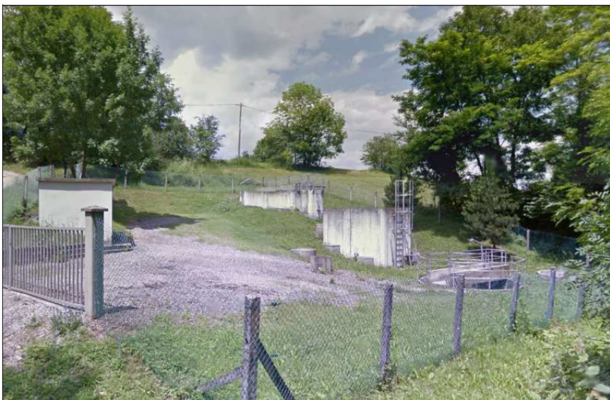
Figure 27 : vue des ouvrages de traitement de la commune de Miribel
