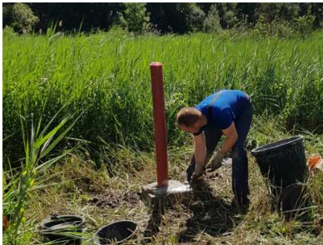
Illustration 7 : Réalisation des têtes des piézomètres
