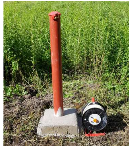
Illustration 7 : Réalisation des têtes des piézomètres
