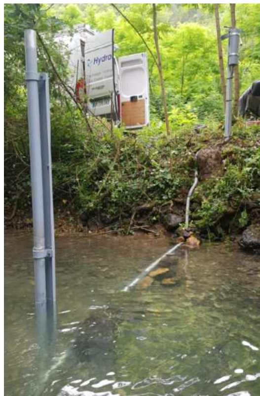
Illustration 8 : Fonçage de pieux dans le lit du Furan
