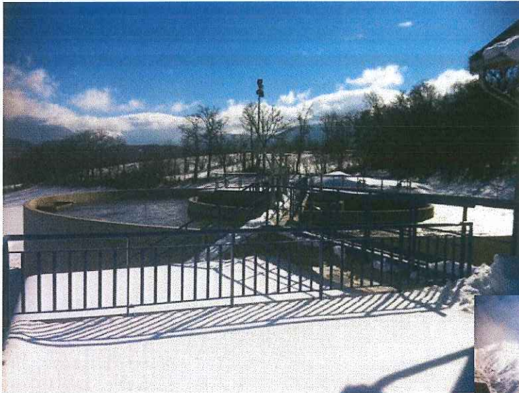
Le bassin d'aération
