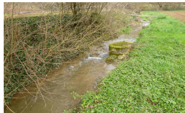
Regard de visite d'assainissement dans le lit mineur
