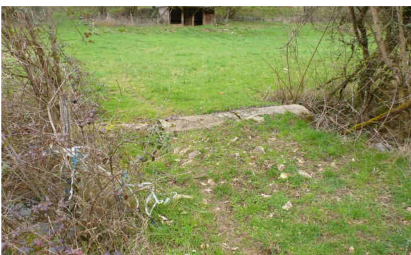
Ouvrage OH4 - buses béton affleurantes
