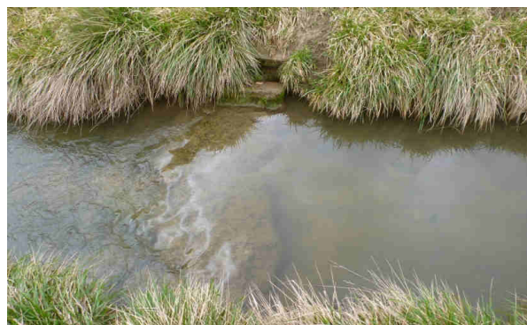
Seuil maçonné (usage : irrigation ?)
