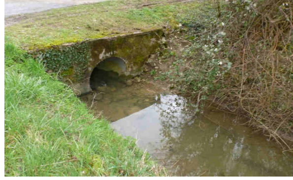
Amont de l'OH3 à l'aval du tronçon
