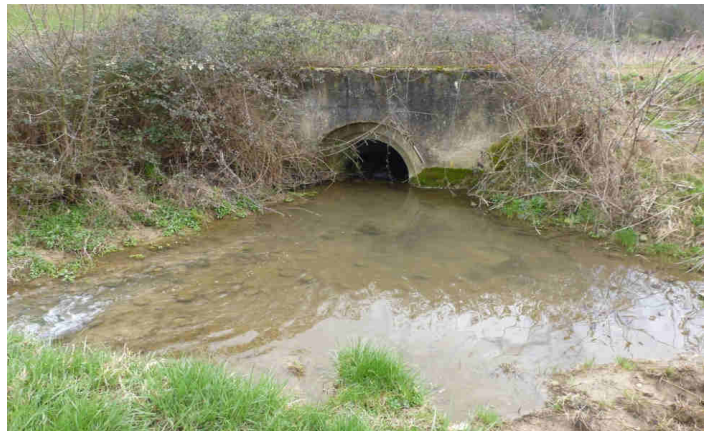
Amont de l'ouvrage de franchissement
