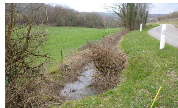
Vue de la partie aval du tronçon
