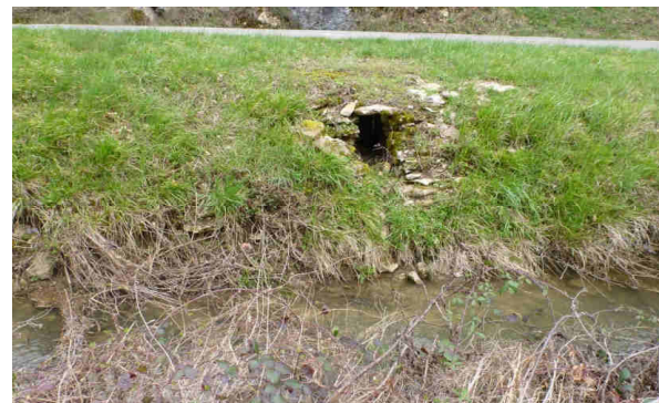
Débouché d'un exutoire pluvial en RG
