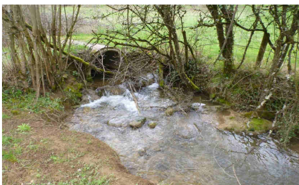
Débouché aval de l'OH3 sur chute
