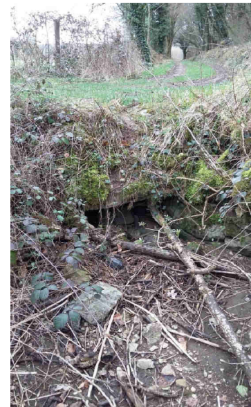
Ouvrage de franchissement aval du lit historique : dallot comblé
