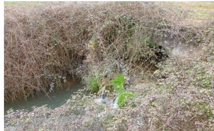
Débouché aval de l'ouvrage de franchissement
