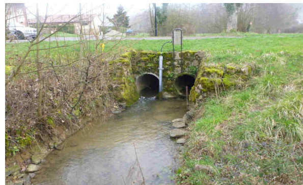
Débouché de l'OH1 avec station limnimétrique
