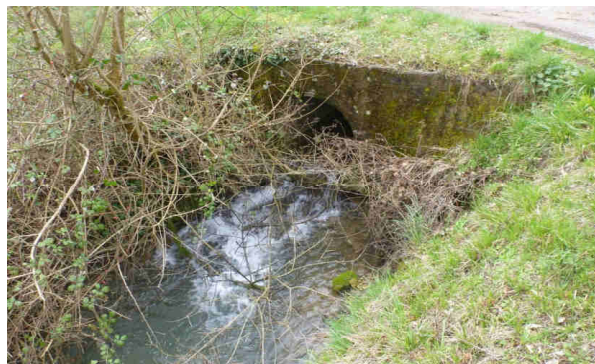
Débouché aval de l'OH3 - chute sur rampe
