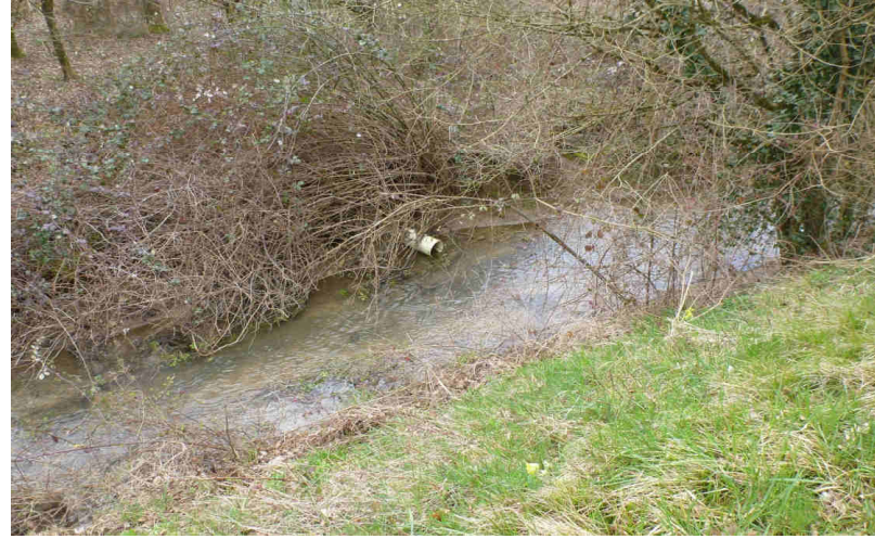
Rejet en RD (lien avec le réseau d'assainissement ou drainage ?)
