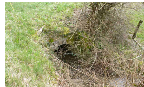
Entonnement amont de l'OH2 à l'aval du tronçon
