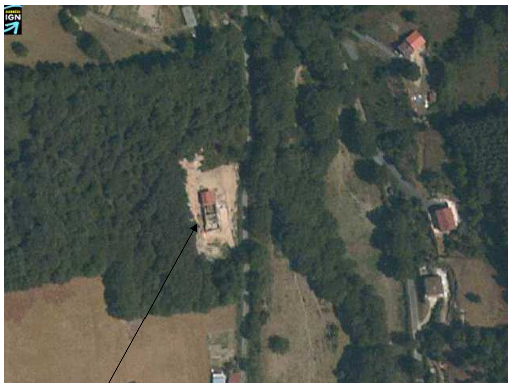
Bâtiment distant du siège d'exploitation
