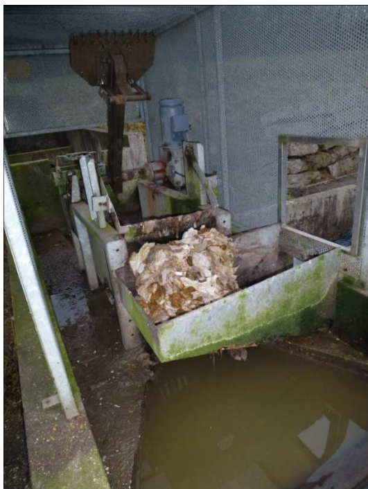
Fig. 4-d : Dégrilleur
