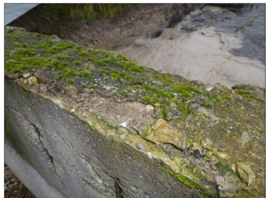
Fig. 4-o : Dégradation important du béton
