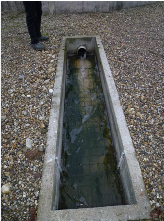
Fig. 4-n : Concrétion calcaire
