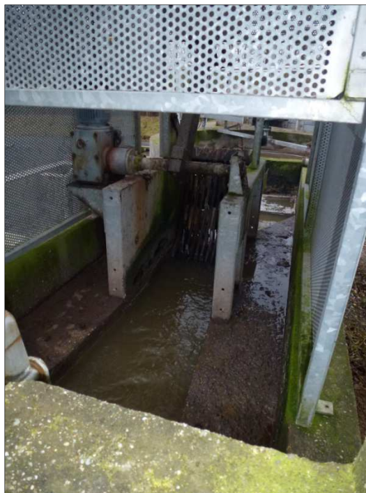
Fig. 4-e : Dessableur dégraisseur
