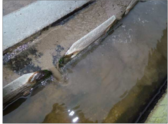
Fig. 4-m : Ferraille apparente
