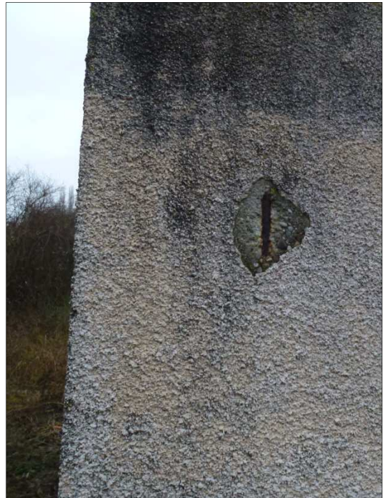
Fig. 4-o : Dégradation important du béton
