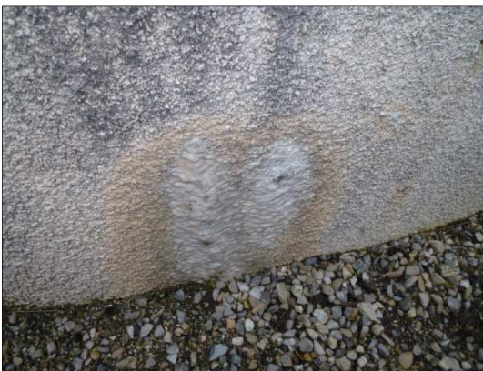
Fig. 4-n : Concrétion calcaire
