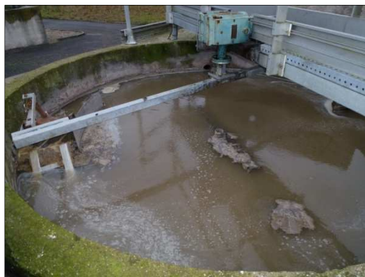
Fig. 4-e : Dessableur dégraisseur
