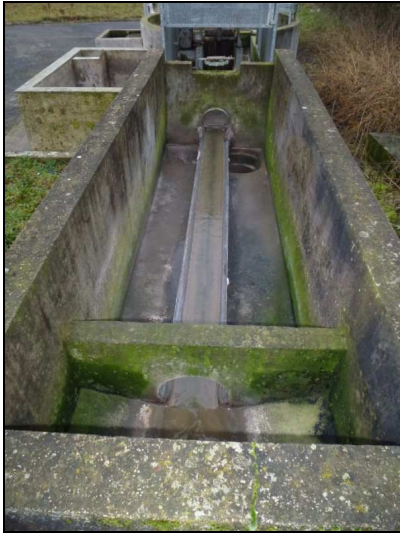
Fig. 3-a : Photographie du dégrilleur
