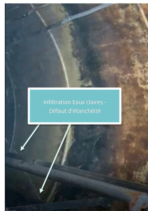
Figure 5: Intrusion d'eaux claires PR station d'épuration
