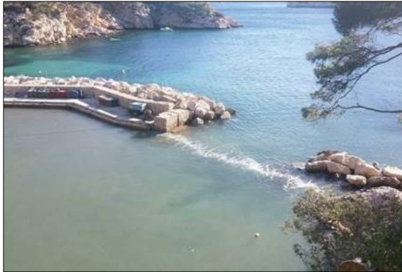
Fermeture du bassin portuaire par le rideau
