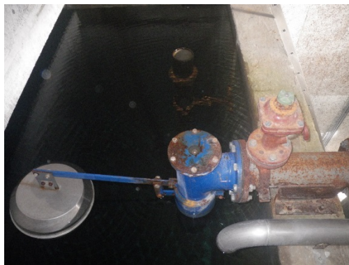
Robinet à flotteur non fonctionnel
