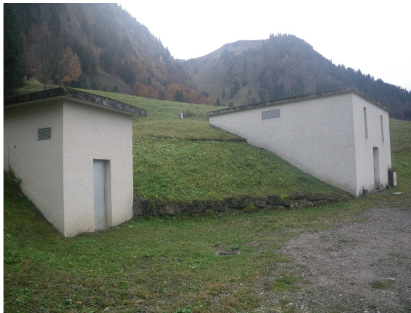
Etat extérieur du réservoir
