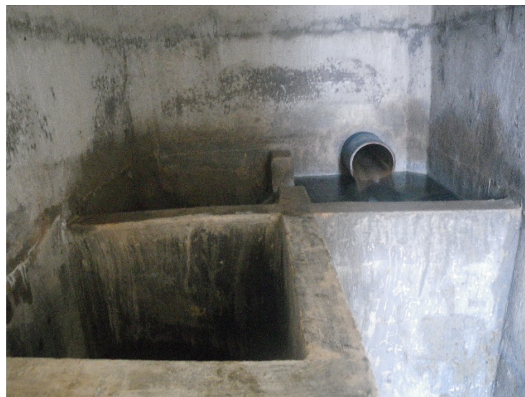
Traces d'infiltration
