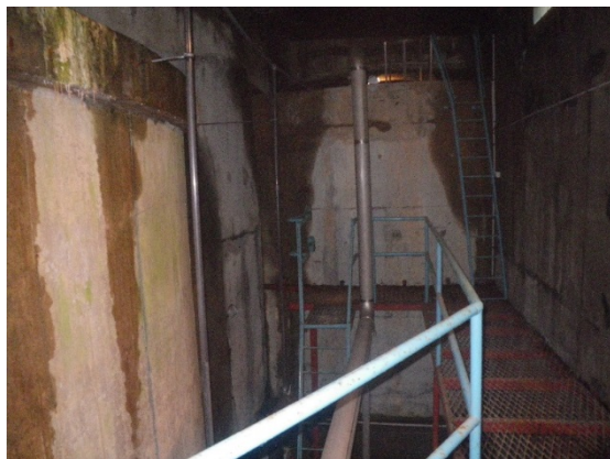
Traces d'infiltration d'eau sur les cuves et muraille extérieure
