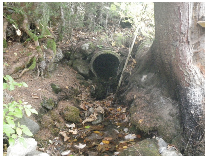
Trop plein du captage
