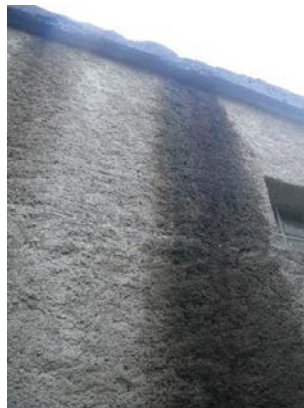
Traces d'infiltration d'eau sur les cuves et muraille extérieure
