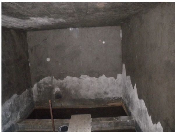
Traces d'infiltration
