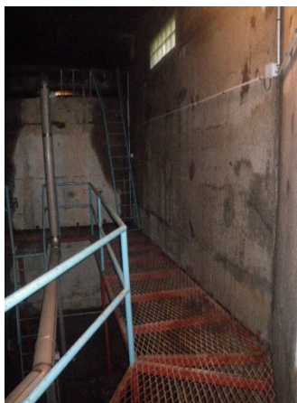
Traces d'infiltration d'eau sur les cuves et muraille extérieure
