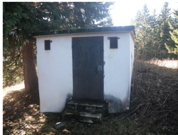
Etat extérieur de l'ouvrage
