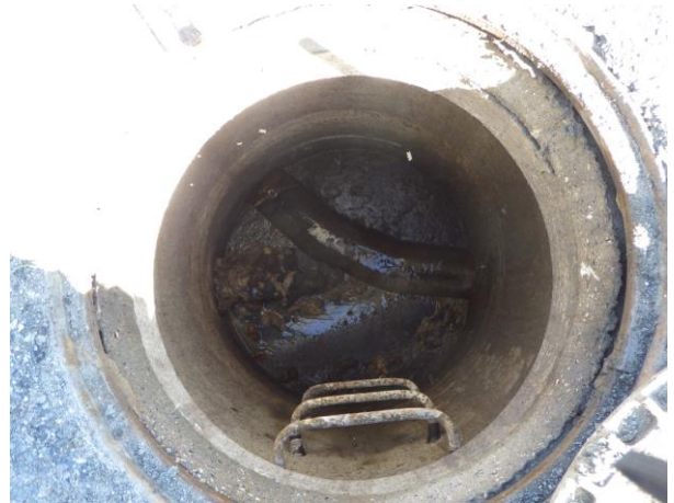
Dépôts – Regard 28 – Route de Dommartin
