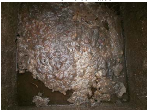
P13 – Dépôts importants, réseau en charge
