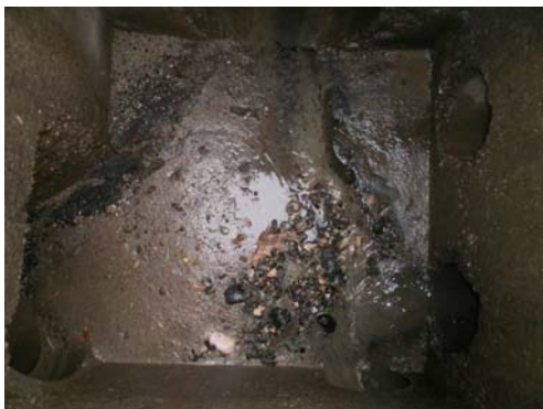
P9 – Déversoir d'orage (présence de dépôts) Vers le lavoir
