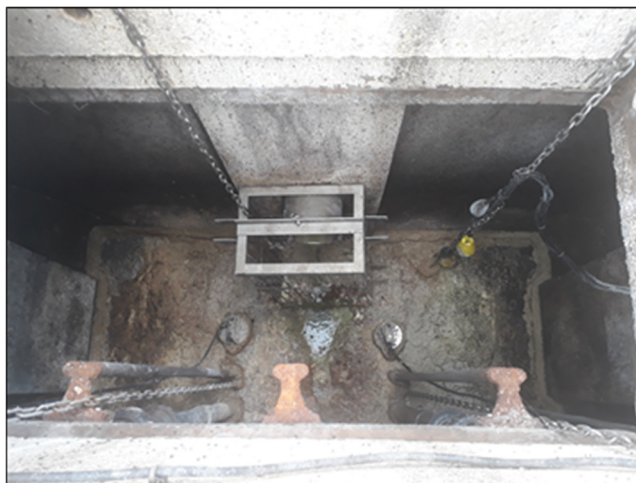
Figure 3 : PR interne à l'entreprise CORNU (dépôts de graisses visibles)
