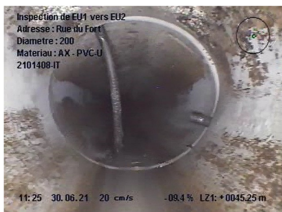
Joint défectueux pénétrant (Tronçon EU1-EU2)
