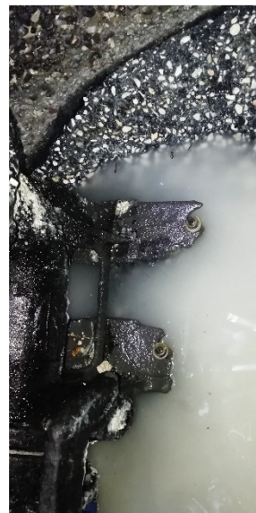
Figure 6 : PR CORNU : conduites de refoulement non étanches
