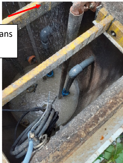
Figure 6 : PR CORNU : conduites de refoulement non étanches
