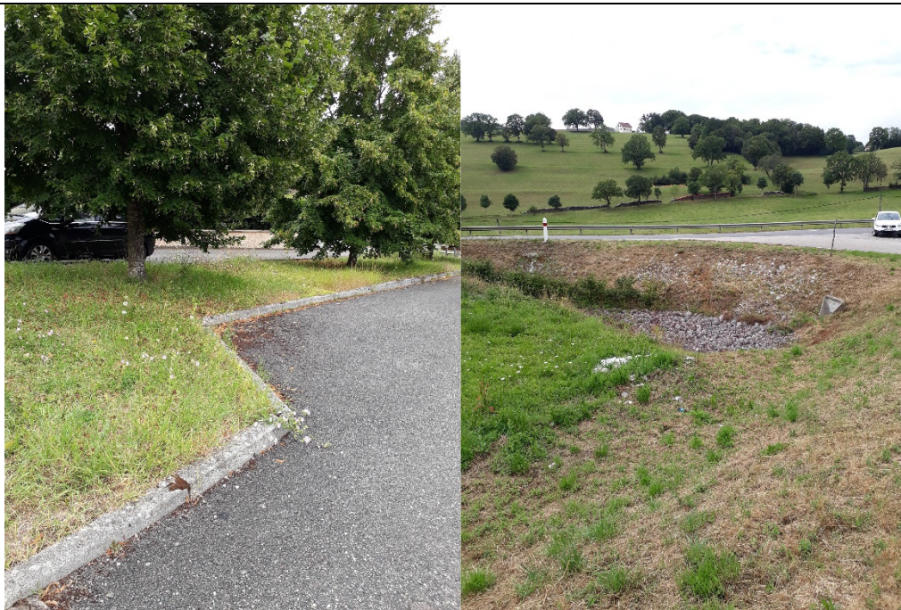
- Figure 25 : Bassin de stockage rue de la Combe Bourgogne (à gauche) et route de Pugy (à droite)
