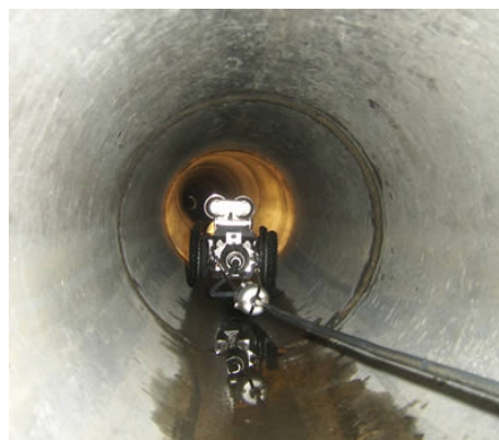
Principe de déroulement d'une inspection télévisée
