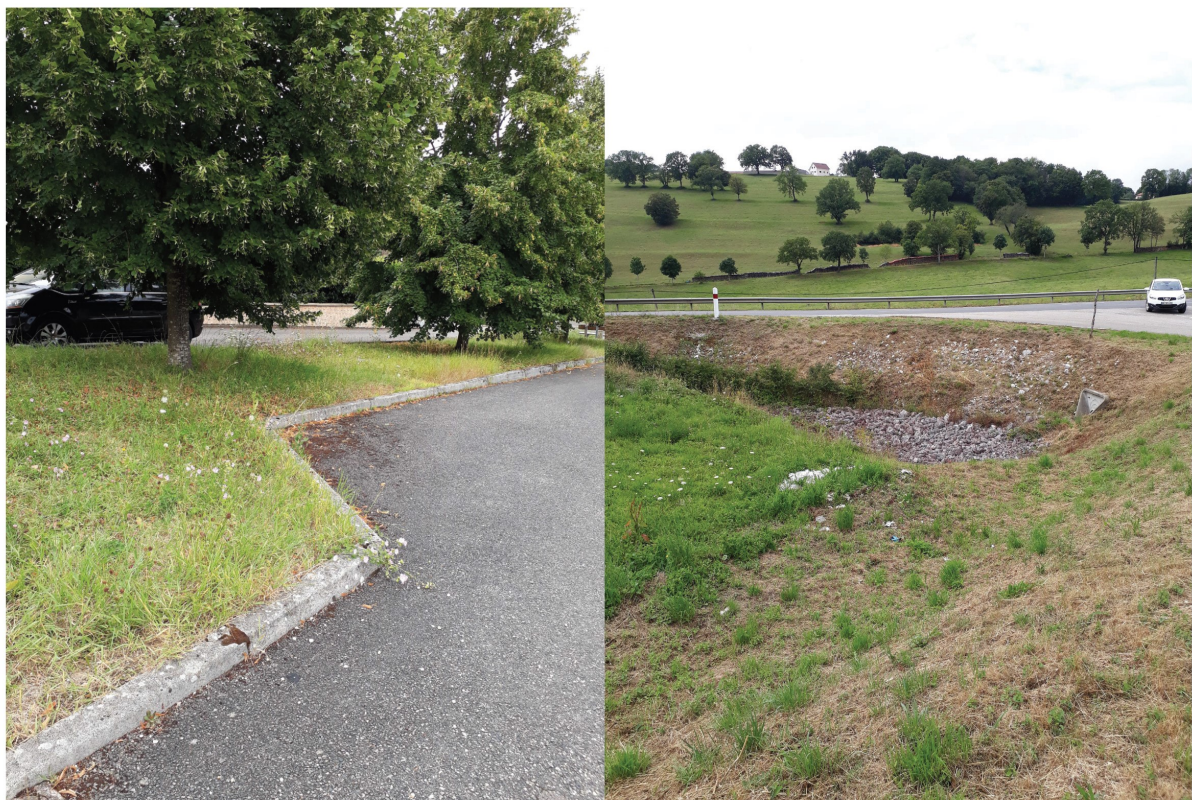
Figure 7: Tronçon Bassin de stockage rue de la Combe Bourgogne (à gauche) et route de Pugey (à droite)
