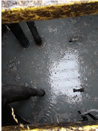
Figure 14 : Effluents chargés du poste de relevage CORNU
