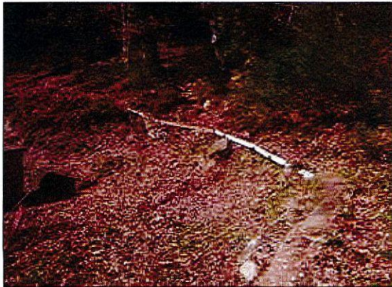
Photo 3 : Conduite secondaire d'amenée des eaux usées à la STEP
