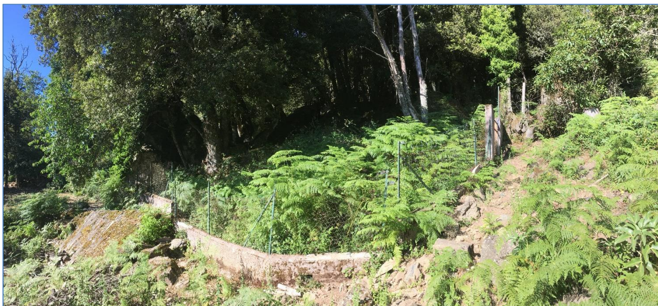
Photo 1 : Source de Pozzo
