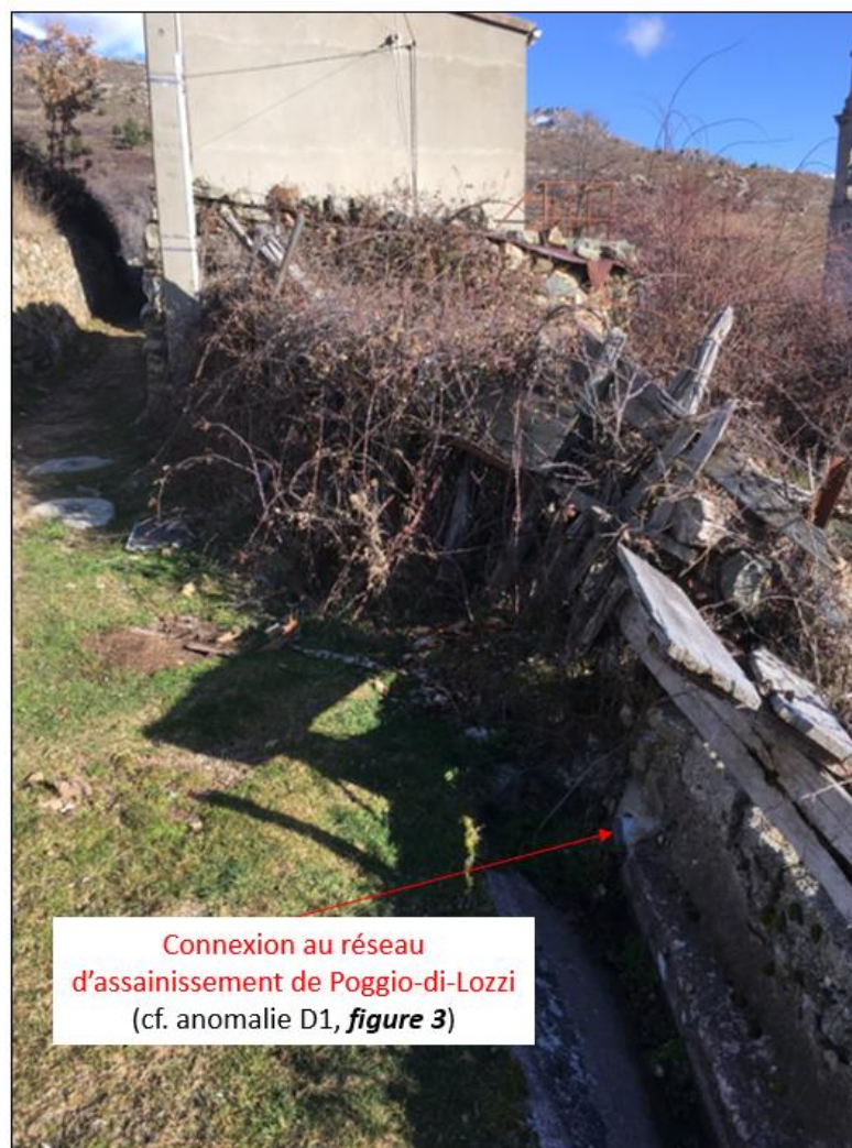
Illustration 15 : Localisation du caniveau pluvial à étanchéifier
