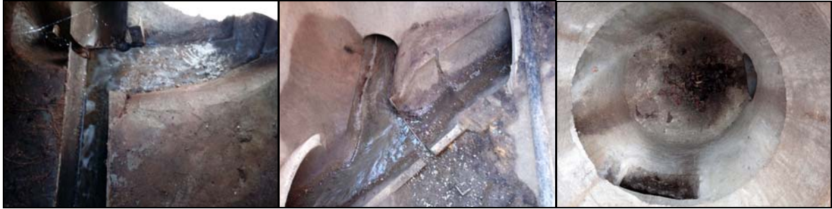
Déversoirs d'orages (DO) 1 et 2 – Arrivée du délestage du DO 3 dans le regard EP5
