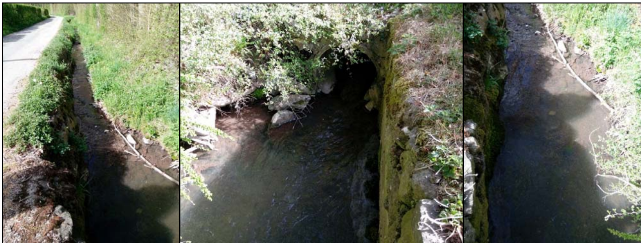
Ruisseau du Serret à la sortie du Bourg – Rejet unitaire n°1 – Pollution visible du ruisseau à l'aval du rejet
