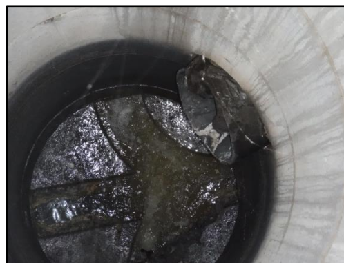
Figure 15 : Exemple de DO en trop-plein
