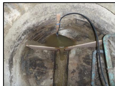
Figure 1 : Exemple d'un seuil
