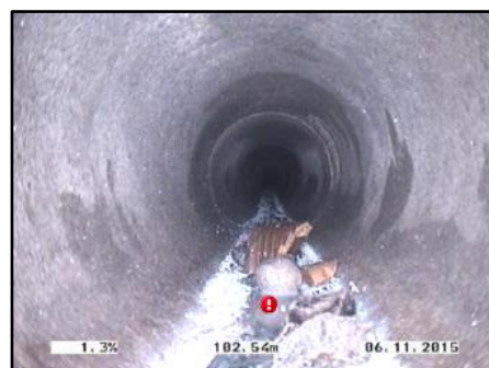
Figure 27 : Photographie de dépôts dans le réseau (AVS – 2015)
