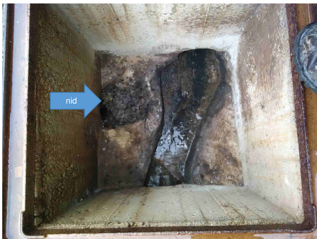
Photo 2 : Déversoir d'orage (pas de débordement malgré la forte pluie du jour). Présence d'un nid de rats.
