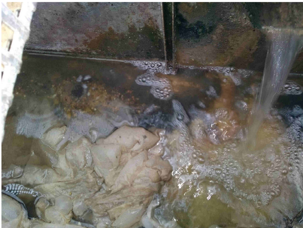
Photo 1 : Arrivée importante d'effluent dilué (pluie) au niveau du dégrilleur
