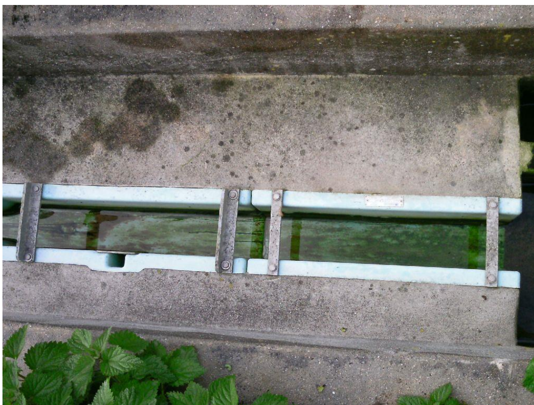
Photo N°26 : Canal de comptage de l'effluent traité.
