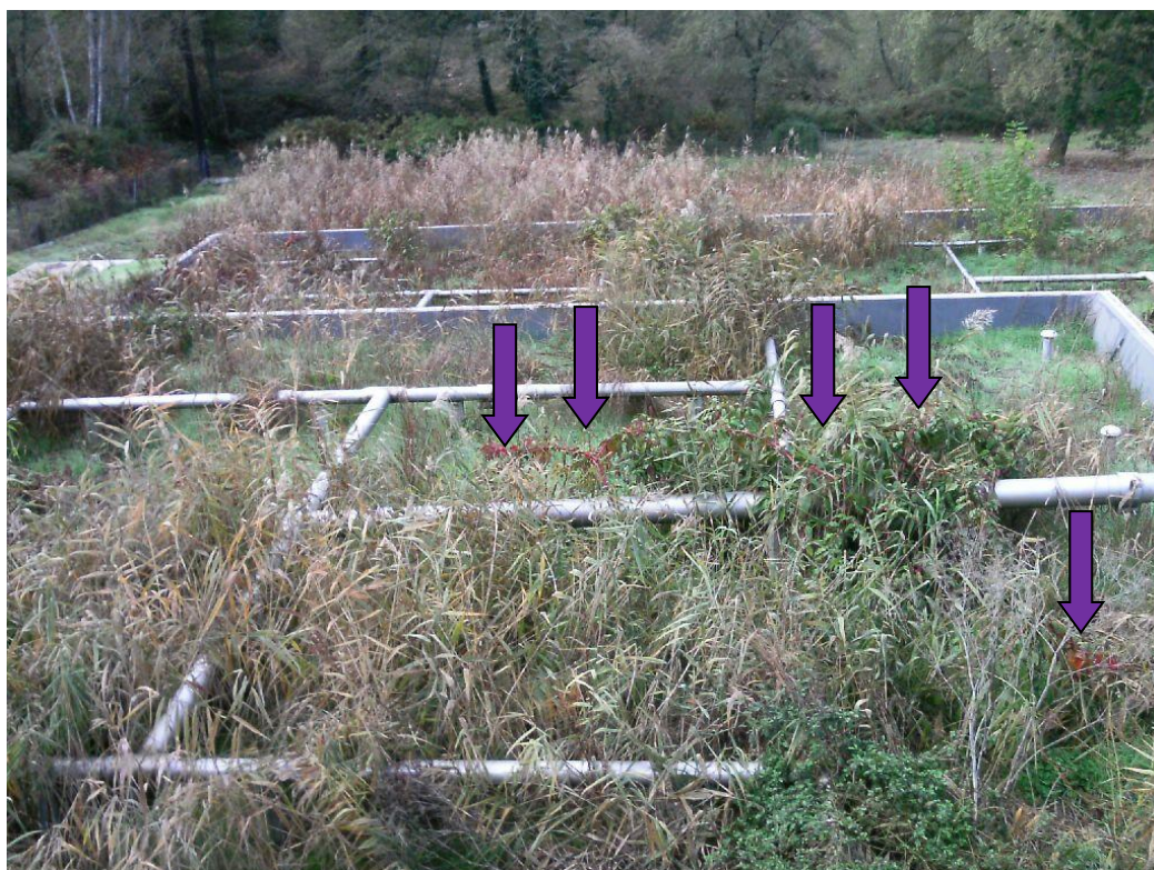
Photo N°15 : Au premier plan, vue partielle du filtre A1. Roseaux qui commencent à s'implanter de manière plus homogène mais présence de plants de raisin d'Amérique à continuer d'éradiquer (couper les grappes et les ensacher puis si possible arracher les pieds avant qu'ils ne deviennent trop gros, sinon les couper à ras).
