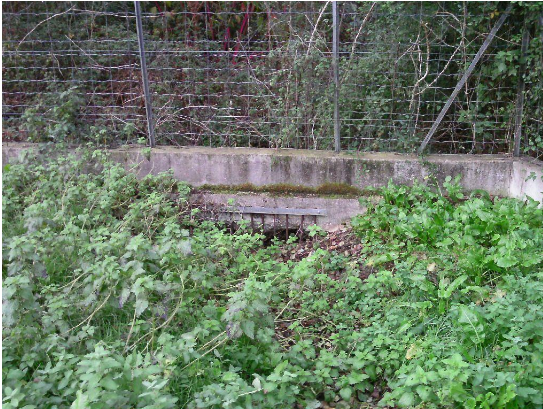
Photo N°35 : Evacuation du pluvial partie droite de la station.
