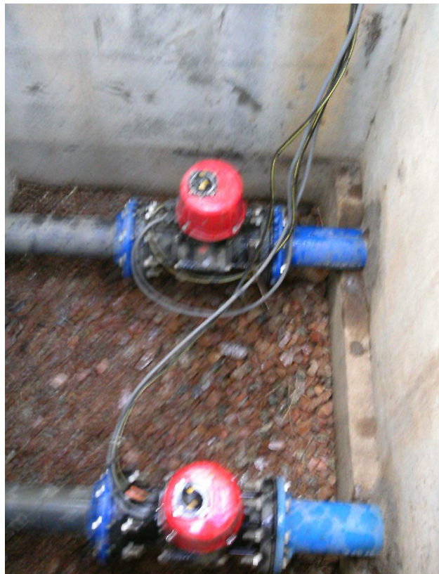
Photo N°29 : Intérieur de l'ouvrage de bâchées alimentant les tertres d'infiltration avec tertres à priori alimentés en continu.
