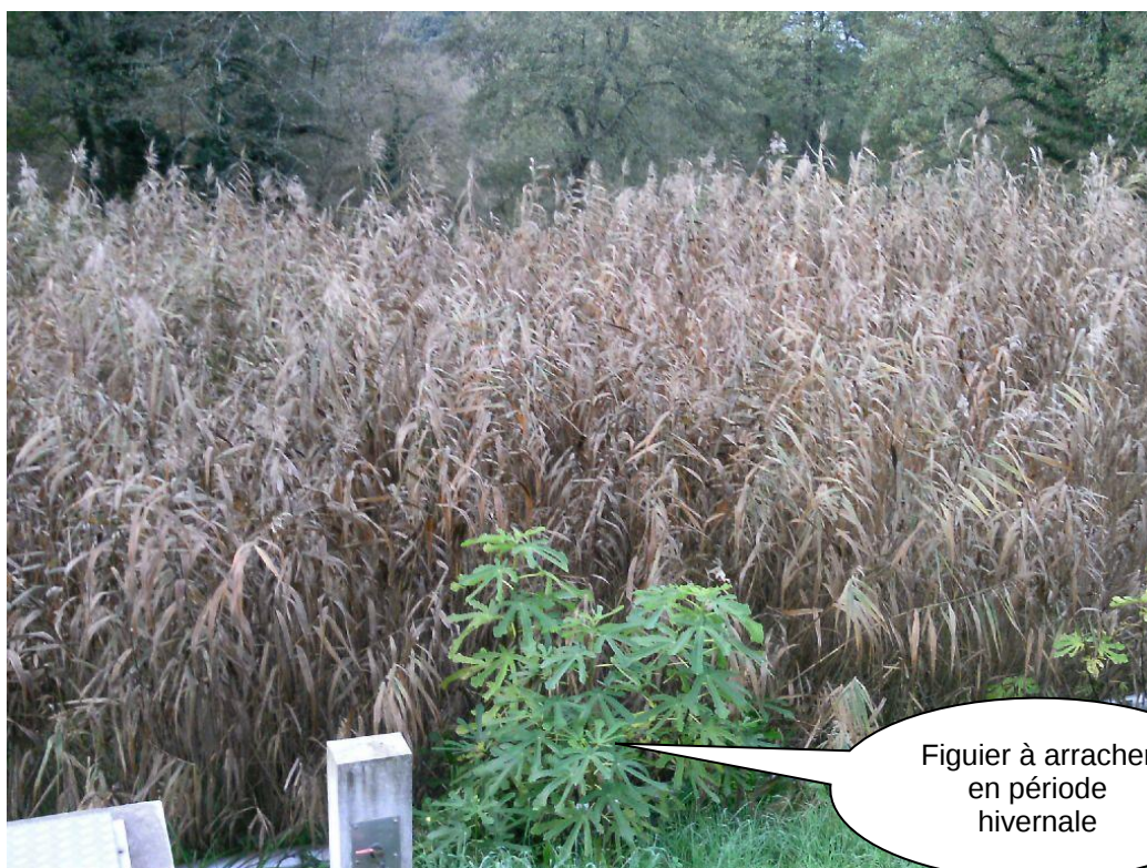
Photo N°22 : Vue du filtre B1 avec roseaux secs qui peuvent être coupés entre décembre et février (période conseillée pour le faucardage des filtres du 1 er et du 2 nd étage avec coupe réalisée à 10 à 20 cm du matériau filtrant + passage râtelier de cantonnier pour évacuation au maximum des tiges et des fanes hors des filtres puis finalisation du nettoyage à l'aide d'un soufflant à feuilles).
