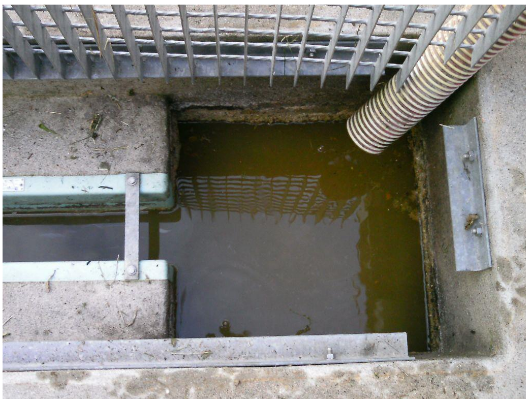
Photo N°5 : Sur-profondeur située en amont du canal de comptage de l'effluent en entrée station régulièrement curé du sable qui s'accumule à l'intérieur. Entretien à réaliser lors de chaque intervention sur la station (réalisée le vendredi). Pour M. MARTINETTI, moins d'arrivées de sable constatées depuis 2019 mais ce serait plutôt des morceaux de goudron de la chaussée.
