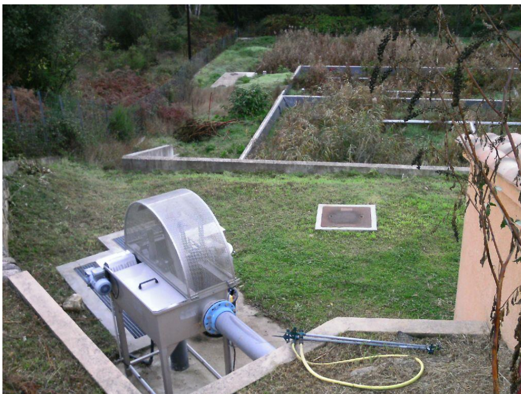
Photo N°3 : Vue du dégrilleur automatique. Bon entretien des abords.
