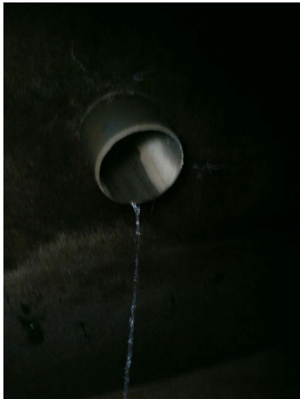
Photo N°28 : Arrivée de l'effluent traité dans l'ouvrage de bâchées alimentant les tertres d'infiltration.
