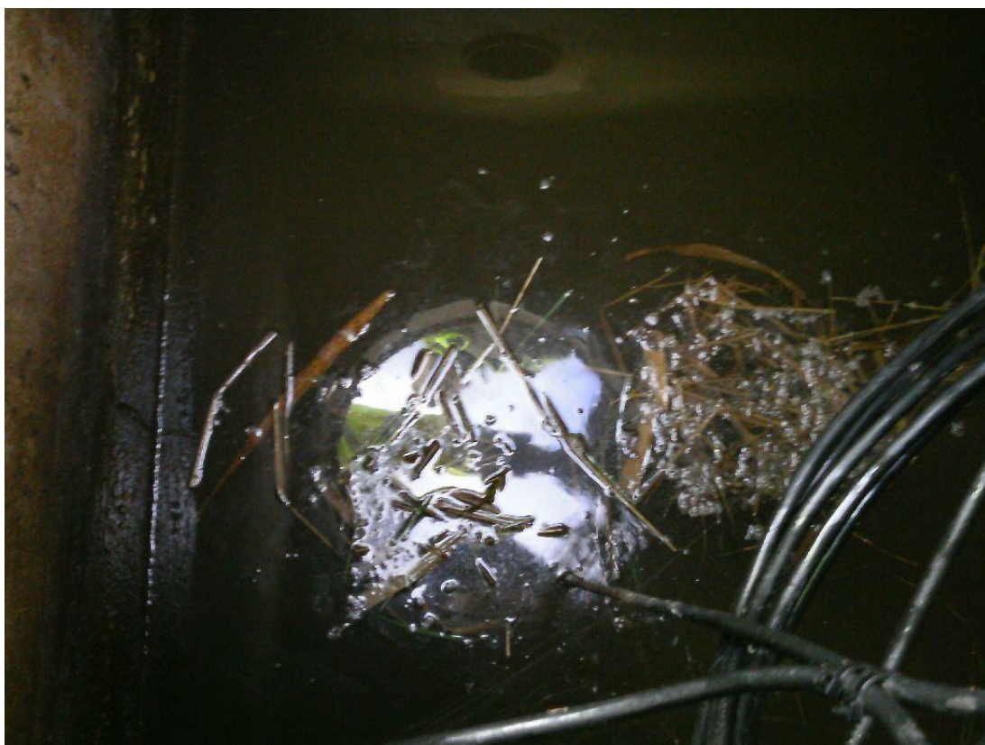
Photo N°20 : Présence de végétation coupée en surface de l'ouvrage de chasse (à enlever) pour éviter qu'elle ne colmate les conduites de répartition de l'effluent en surface des filtres du 2 nd étage.
