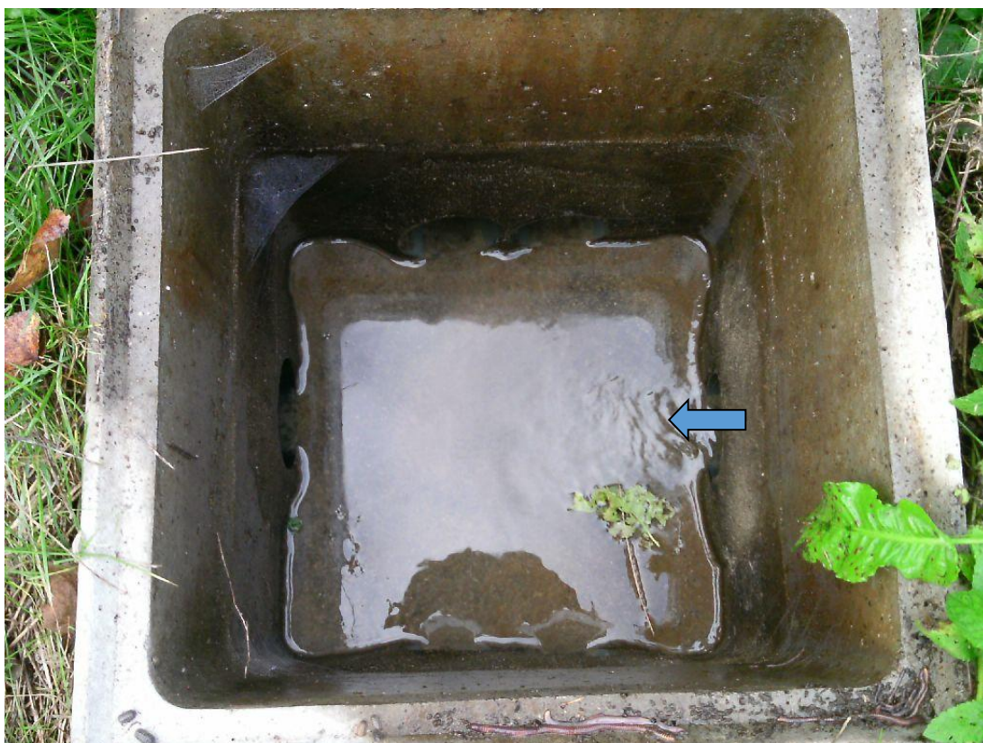
Photo N°33 : Regard de répartition le plus éloigné du canal de comptage alimenté ce jour.
