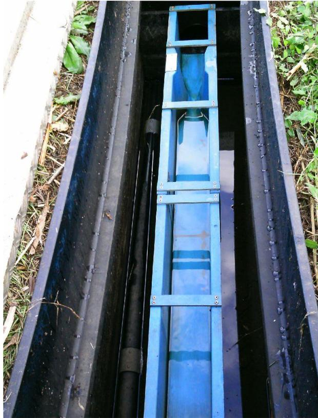
Photo N°23 : Canal de comptage de l'effluent traité.
