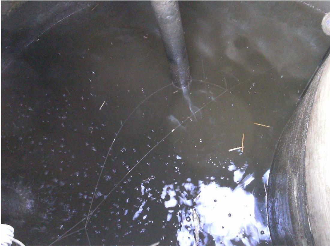
Photo N°17 : Intérieur du système de bâchées N°2 alimentant les filtres plantés de roseaux du 2nd étage.
