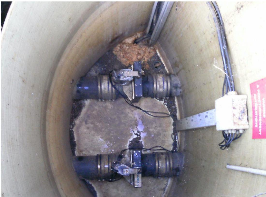
Photo N°18 : Système de vannes mécaniques permettant l'alimentation des 2 FPR du 2nd étage (une vanne associée à un filtre).
