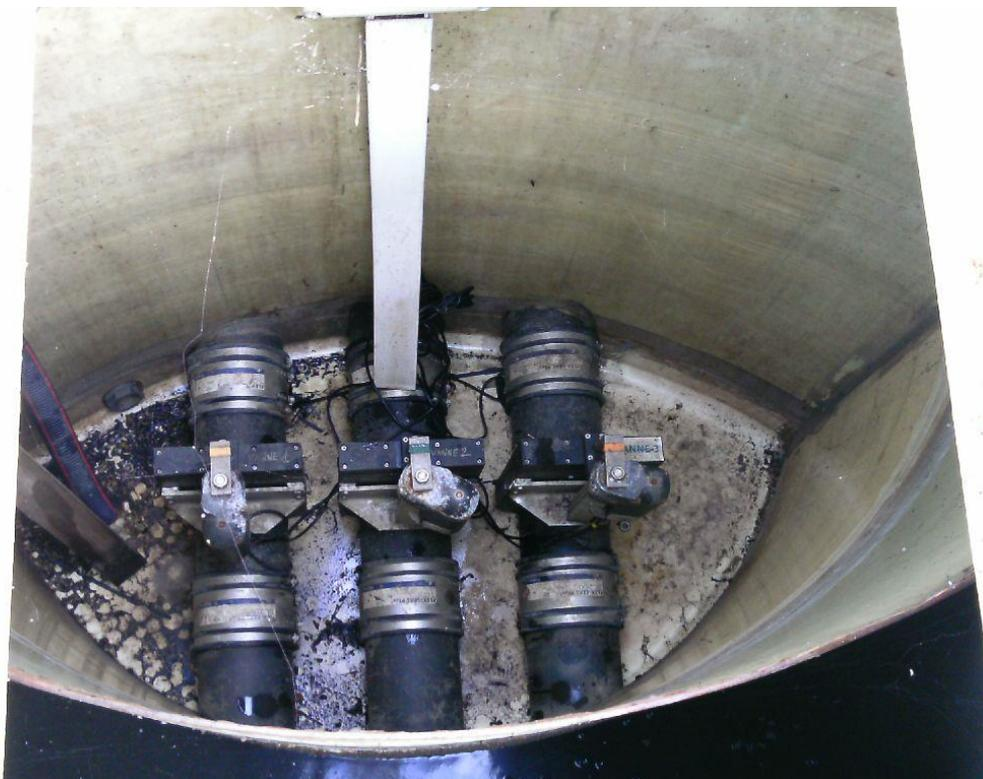
Photo N°10 : Système de vannes mécaniques permettant l'alimentation des 3 FPR du 1<sup>er</sup> étage (une vanne associée à un filtre).
