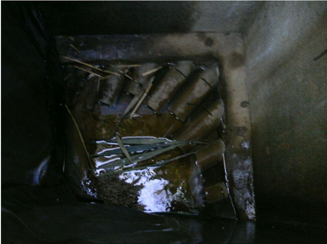
Photo N°21 : Intérieur du regard de reprise des drains du filtre B2.
