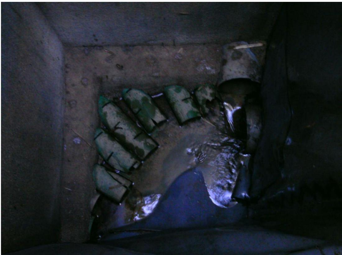
Photo N°22 : Regard de reprise des drains du filtre B1.
