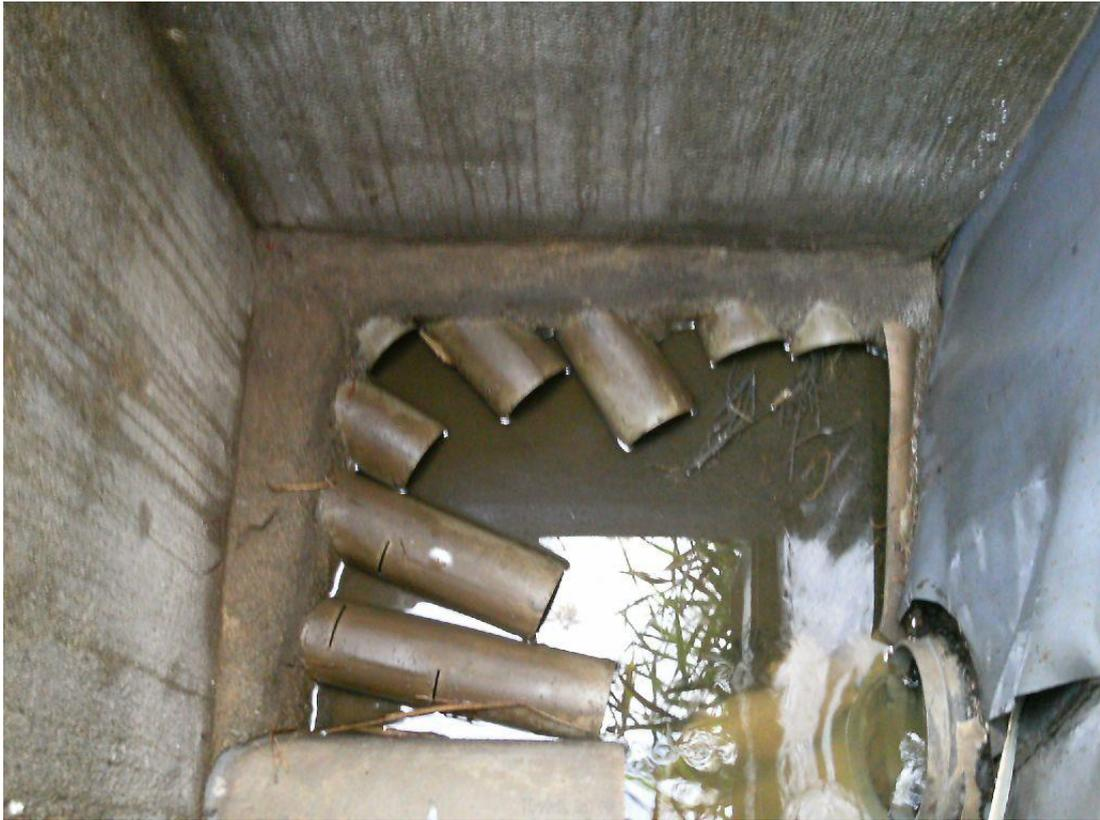
Photo N°15 : Regard de reprise des drains du filtre A2.
