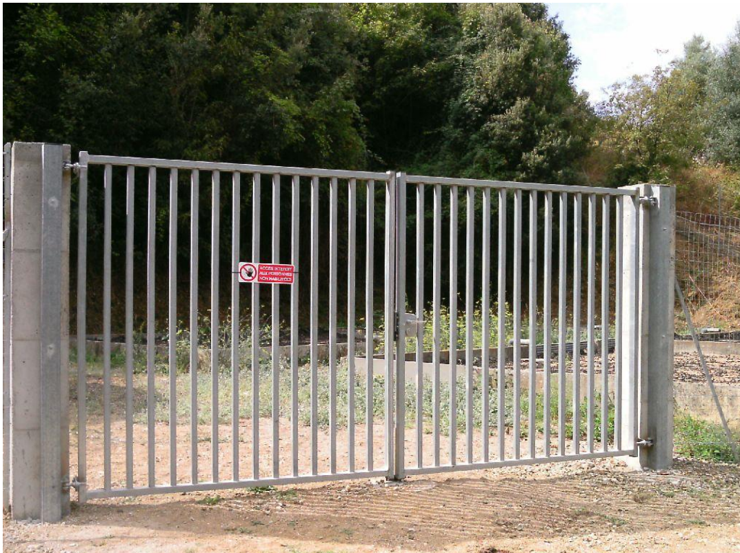
Photo N°14 : Accès au niveau des lits de séchage des boues.
