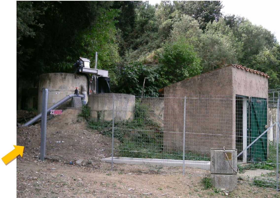
Photo N°13 : Accès prétraitements et local technique réalisé
