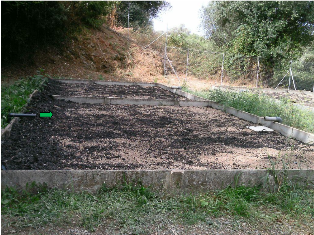
Photo N°25 : Lit de séchage sur lequel le poste de reprise des flottants du clarificateur déverse.
