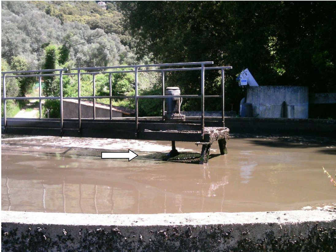
Photo N°9 : Photo prise le 05/05/21 avant que la lame crénelée du dégazeur ne soit remplacée. On voit que le niveau dans le bassin d'aération est au même niveau que la partie supérieure de la volute.
