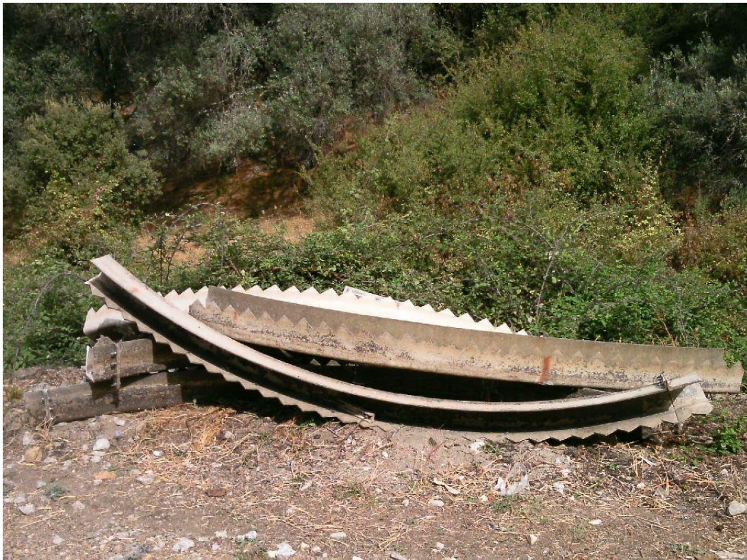
Photo N°32 : Ancienne goutte de reprise de l'effluent du clarificateur qui devrait être évacuée.
