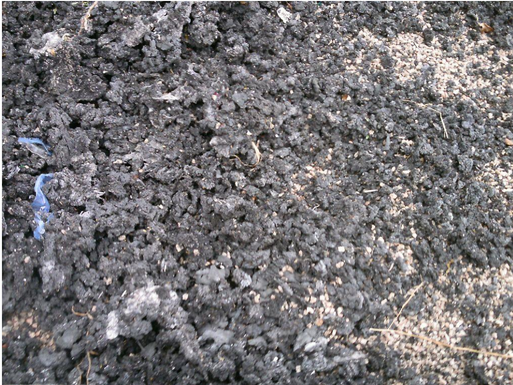
Photo N°27 : Boues sèches à évacuer des lits et matériau filtrant récemment mis en place à l'intérieur des lits de séchage. Le SATESE conseille de réaliser hors période estivale (de janvier à mai et d'octobre à novembre) un soutirage par mois de boues sur deux lit de séchage en ayant pris soin d'arrêter durant au minimum 2 heures la recirculation (d'après le débit de la pompe d'extraction alimenter chaque lit durant environ 20 à 22 minutes).
