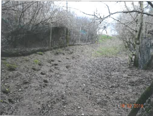
Pied du talus aval du barrage nombreux terriers sous la partie arborée
