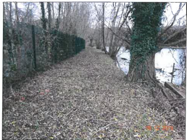
Crête du barrage, tête de talus amont et petit talus aval Arbres indésirables
