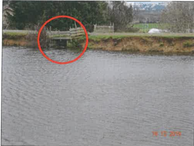
Évacuateur de crues érosion notoire de la tête du talus amont due aux petites vagues
