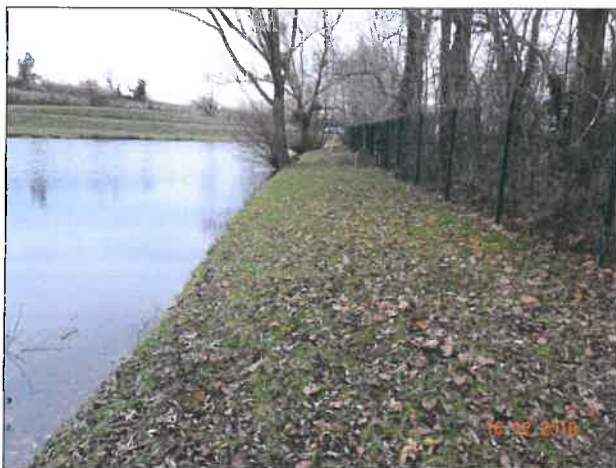
Crête du barrage, tête de talus amont et petit talus aval Arbres indésirables
