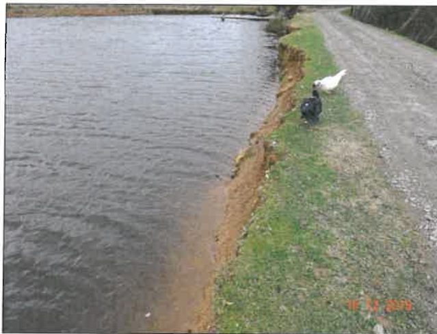
Crête et partie haute du talus amont érosion notoire due aux vagues
