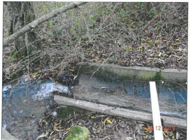
Évacuateur de crues érosion notoire de la tête du talus amont due aux petites vagues
