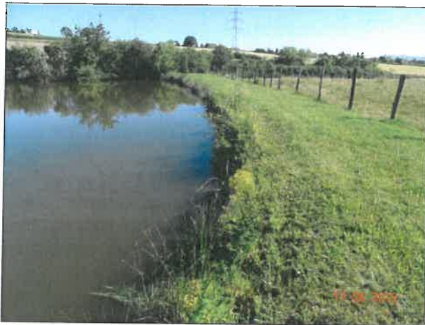
Deux vues de la crête de la partie du barrage perpendiculaire au thalweg légère érosion à la ligne d'eau
