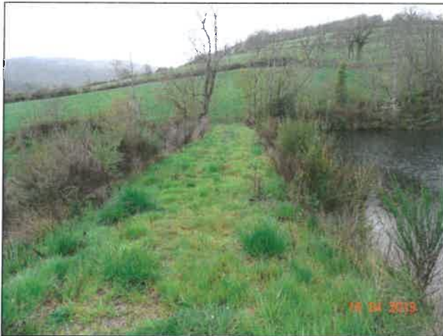
2 vues de la crête du barrage Tête de talus amont non entretenue
