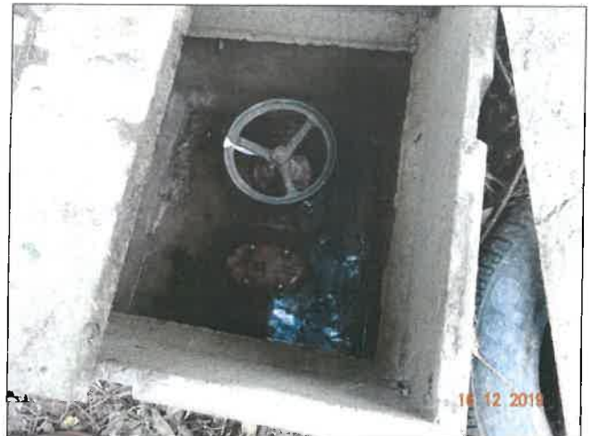
Chambre de vanne en pied aval du barrage
