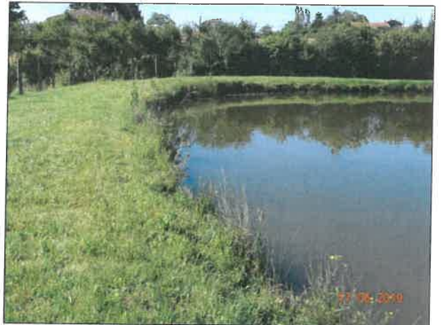
Deux vues de la crête de la partie du barrage perpendiculaire au thalweg légère érosion à la ligne d'eau
