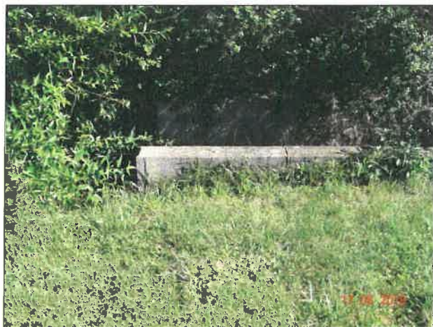
Évacuateur : chenal en maçonnerie avec seuil "arrondi"
