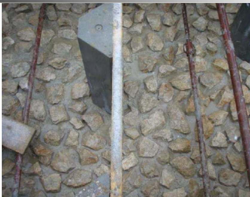
Figure 30 : Exemple à suivre pour la constitution du fond de la passe à poissons en galet
