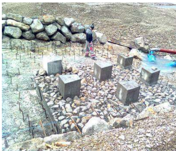
Figure 27 : Passe à poissons pendant le chantier (seuil des Pues sur la Drôme)
