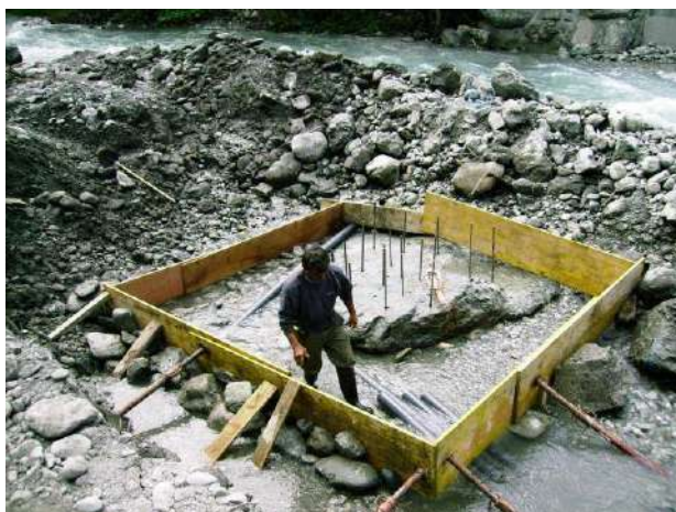
Figure 34 : Exemple de mise en œuvre de tubes acier sur le substratum rocheux pour assurer l'ancrage de la fondation d'une culée de pont (Hautes-Alpes, 2009)
