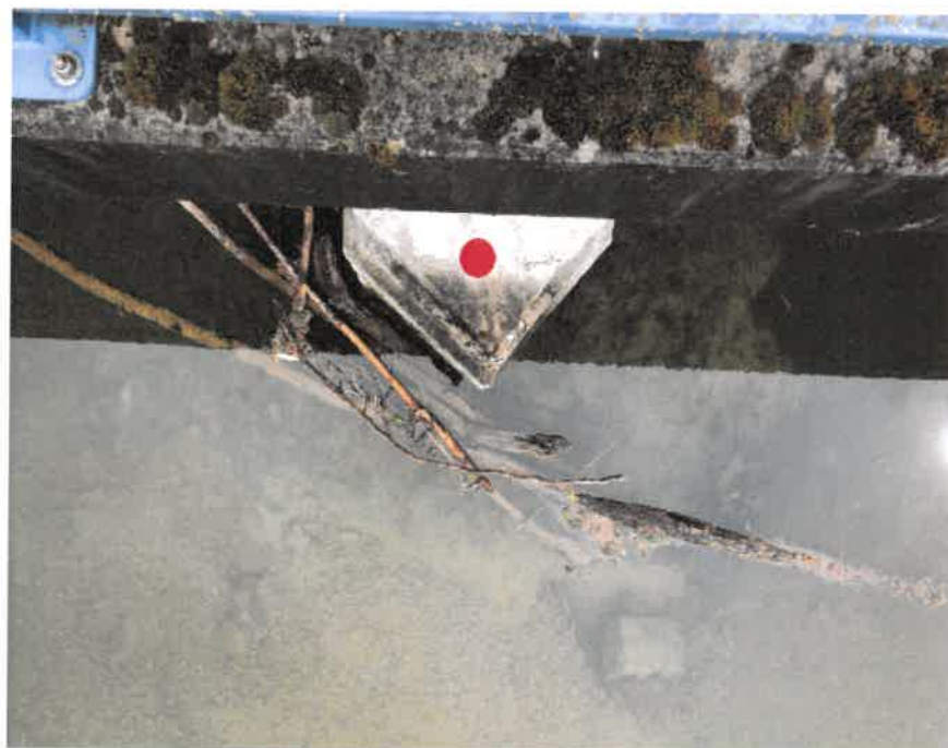
Implantation des sondages sur les piles
