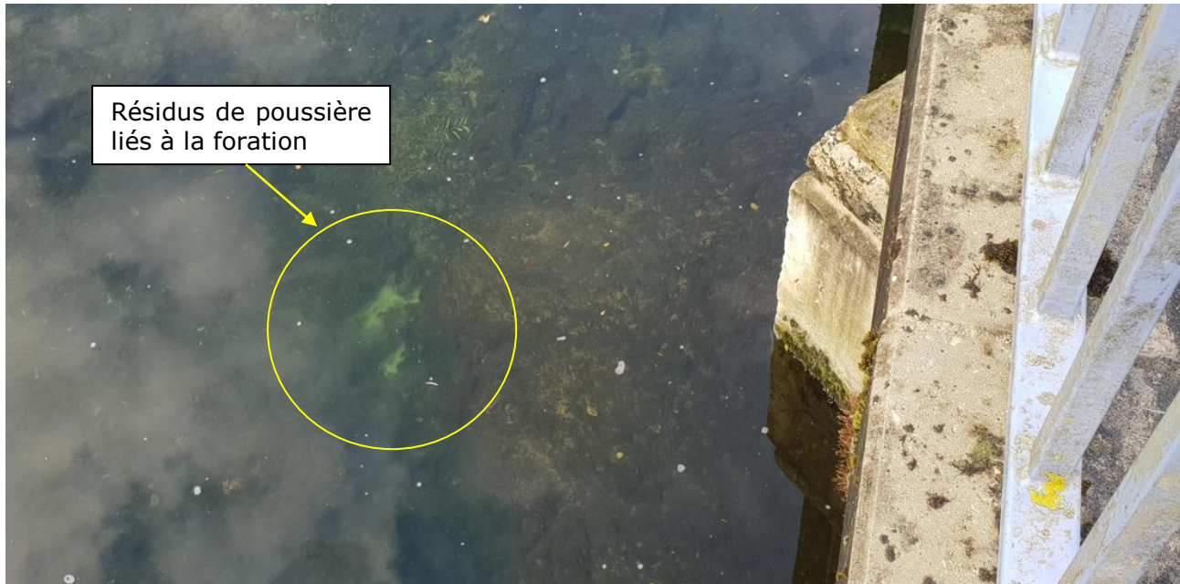
Vue depuis la pile P2 lors de la foration (26/10/2021)
