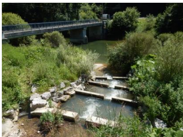
Figure 10. Passe à poissons de type "pré-barrages" de la Vaclusotte
