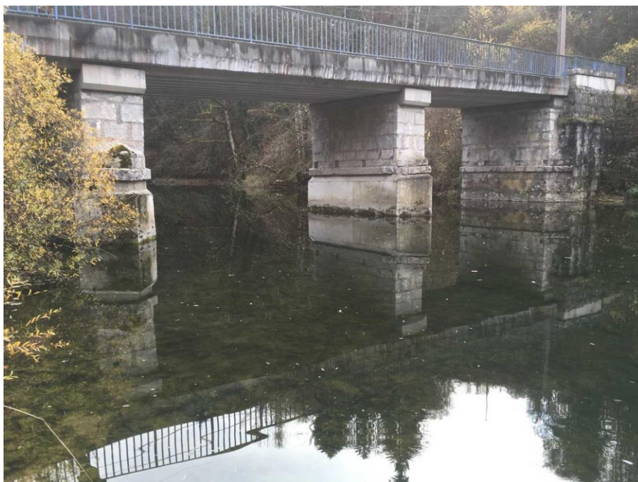
photographie du Pont de la Vaclusotte, le 14 novembre 2018
