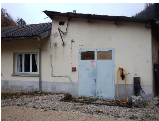
Fig. 53. Signe d'instabilité du premier bâtiment et signe de fissures en berge
