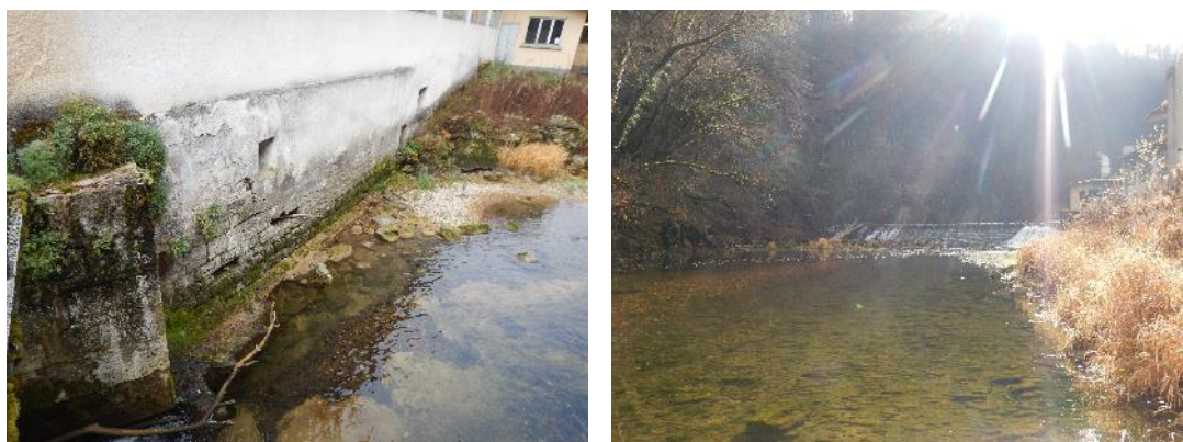
Fig. 56. Bâtiments situés à l'aval de l'ouvrage
