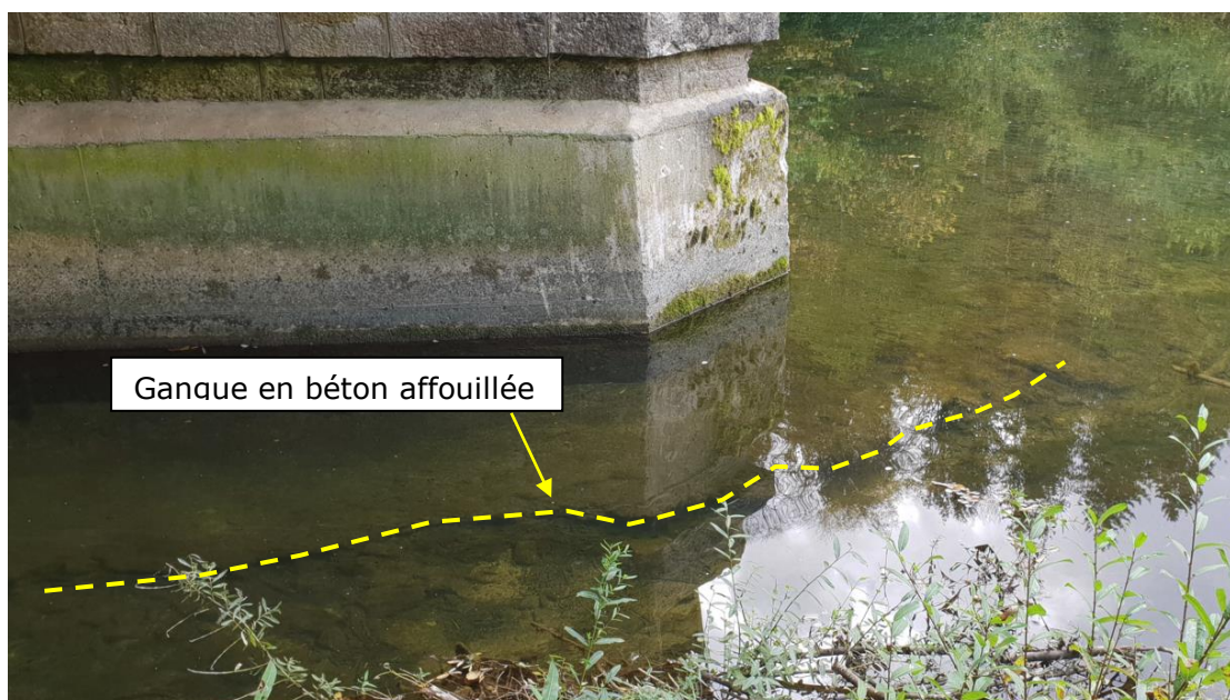
Vue de la base de la pile P1 depuis la culée C0
