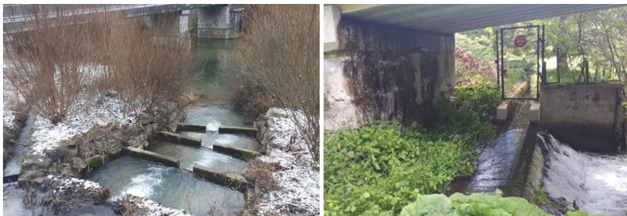
(à gauche) Passe à poissons (à droite) Canal d'alimentation (source : syndicat mixte Doubs Dessoubre)
