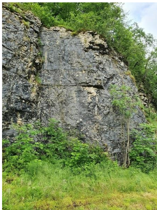
Affleurement rocheux visible côté Nord de la route à proximité du pont
