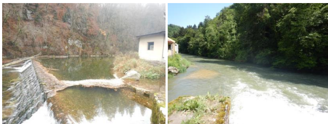
Fig. 37. Seuil de la Voyèze et vue aval
