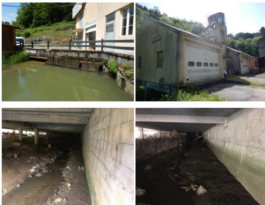
Fig. 39. Canal usinier du site de la Voyèze
