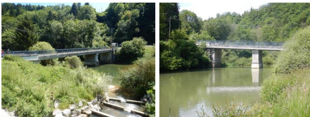
Fig. 40. Photo de la face amont (gauche) et aval (droite) du pont de la Voyèze
