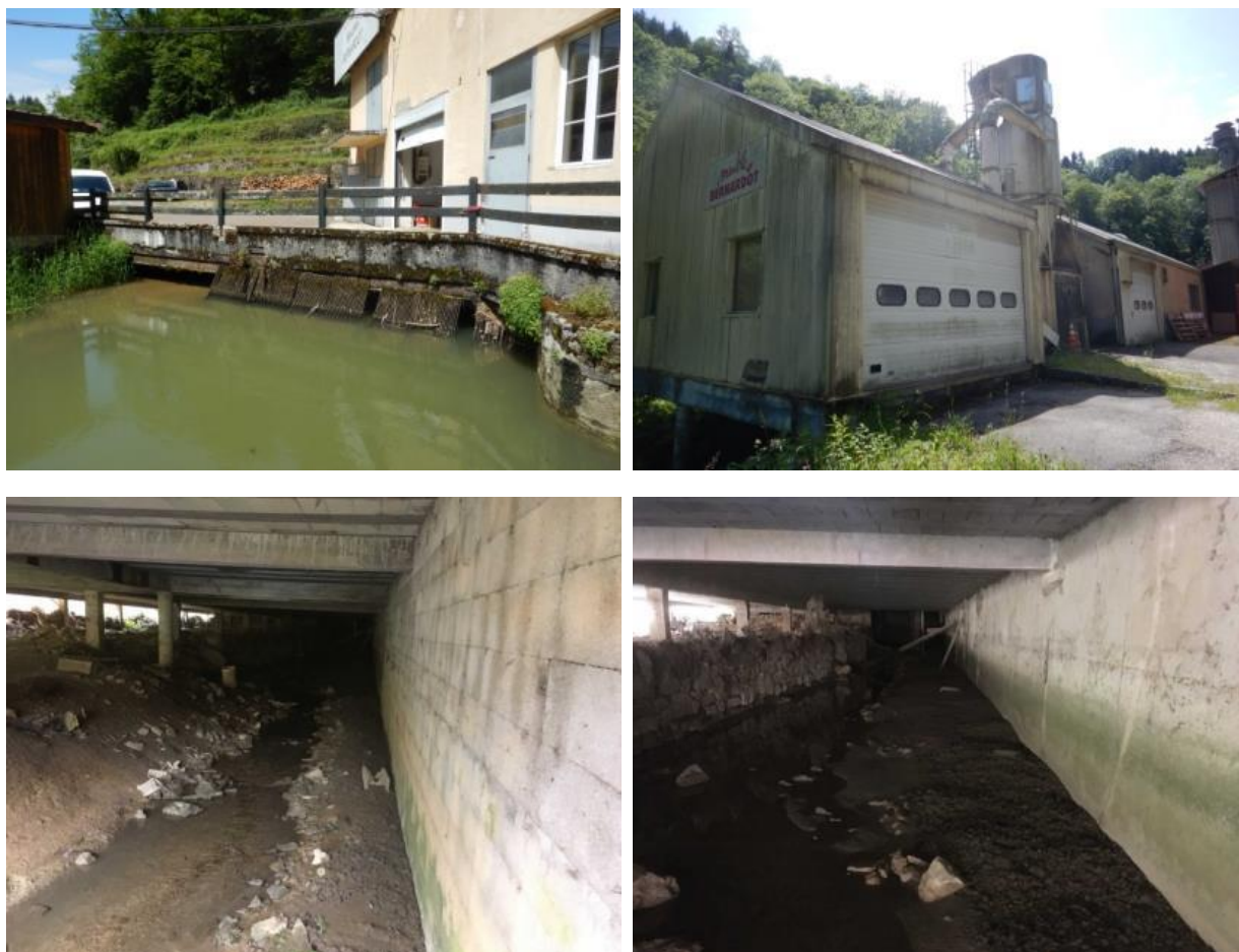
Figure 5. Canal usinier du site de la Voyèze
