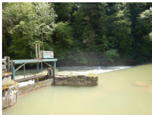
Fig. 38. Vanne de décharge du seuil de la Voyèze
