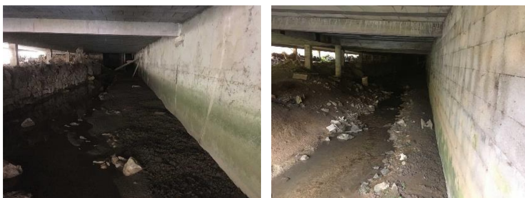
Fig. 55. Canal usinier alimenté par l'aval
