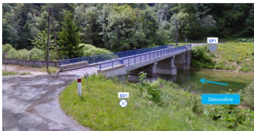
Fig. 48. Localisation des sondages SD1 et SP1
