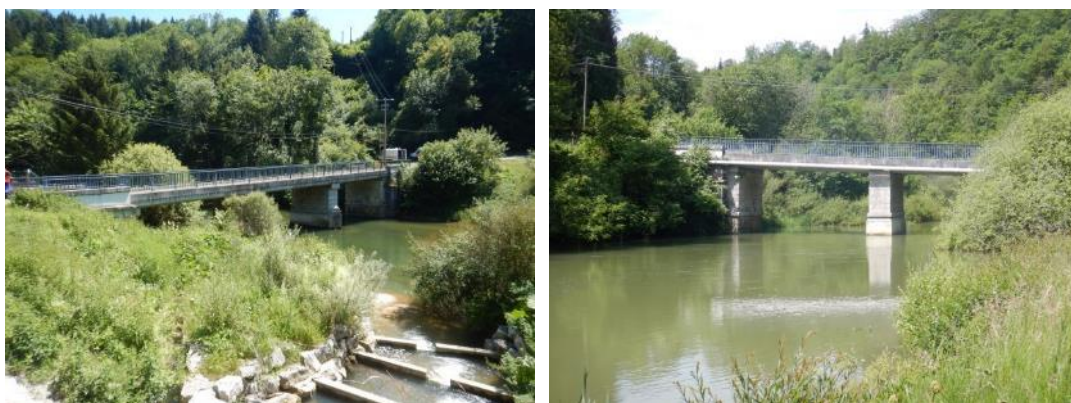
Fig. 40. Photo de la face amont (gauche) et aval (droite) du pont de la Voyèze
