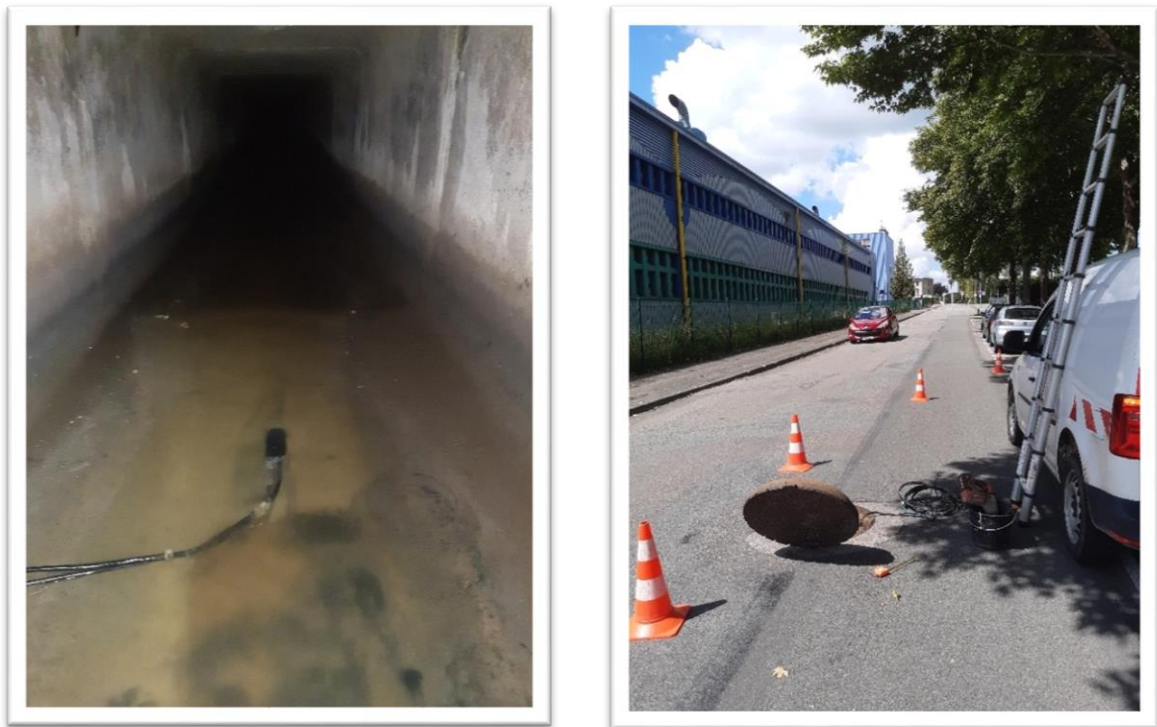
Figure 17 : Points de mesures P2 (à gauche) et situation du point P3 (à droite)
