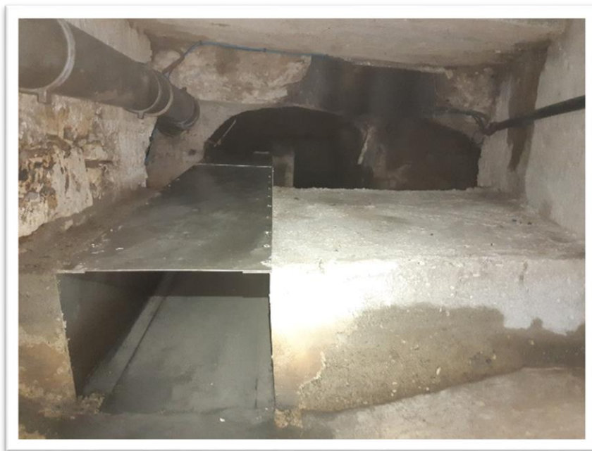
Figure 12 : Dalot au droit du déversoir d'orage Jaurès-Lavandières
