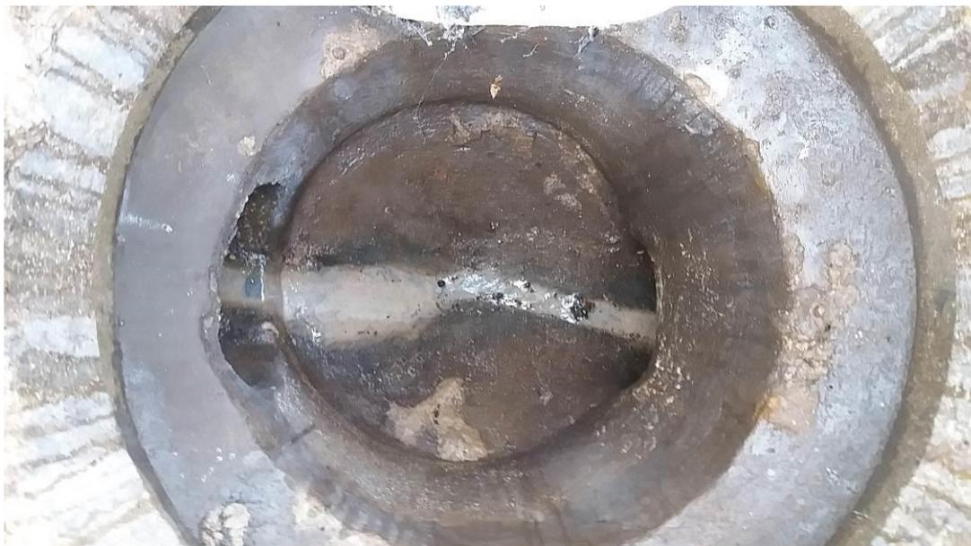
Figure 14 : Traces de mise en charge
