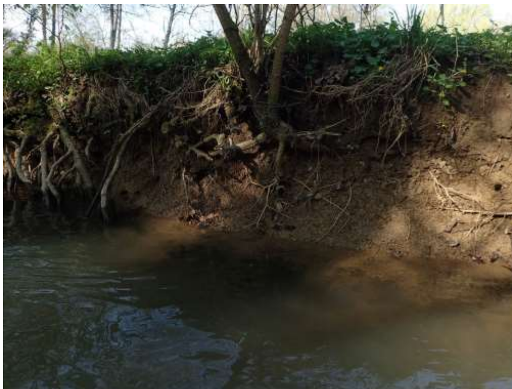
Figure 49 : Erosion de berge en rive gauche de la Buthiers, en amont du pont de la route départementale Source : GRAINEau
