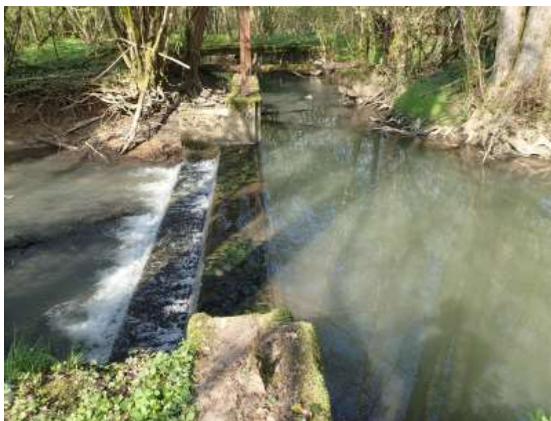
Figure 48 : Photographie du seuil de stabilisation
