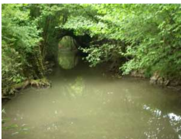
Photo 4 : Chenal lentique en amont de la station BRE au droit du pont de la route de They (source : ARALEP)
