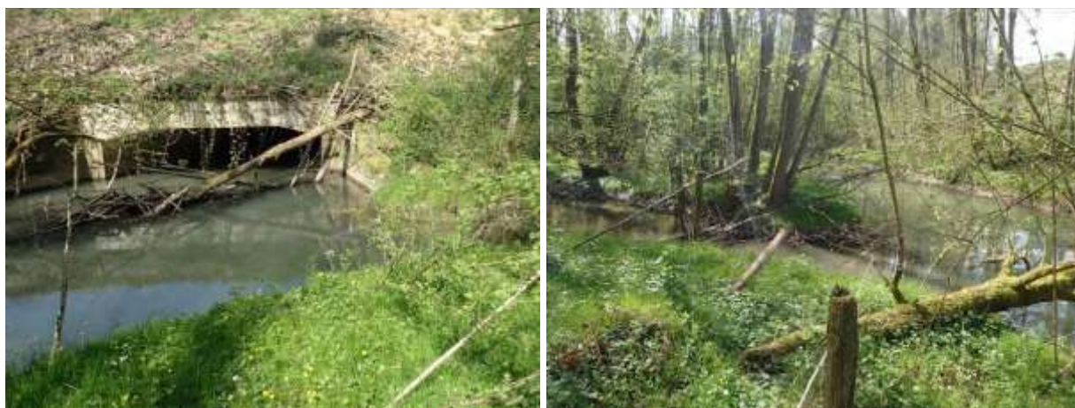
Figure 41 : La Buthiers en amont de l'étang. Photographie de gauche : ouvrage de franchissement de la N57. Photographie de droite : séparation de la Buthiers en 2 bras Source : GRAINEau et SIGosphere
