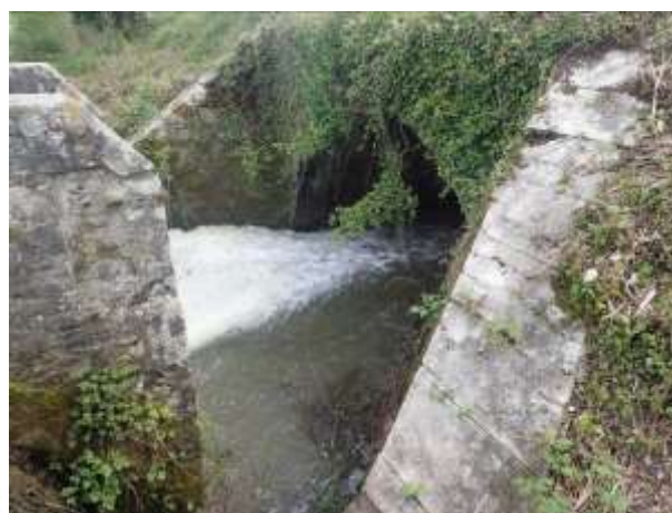
Figure 32 : Coupe et photographie de l'ouvrage hydraulique (pont) à l'aval immédiat du moulin de Buthiers Source : SIGosphere et GRAINEau
