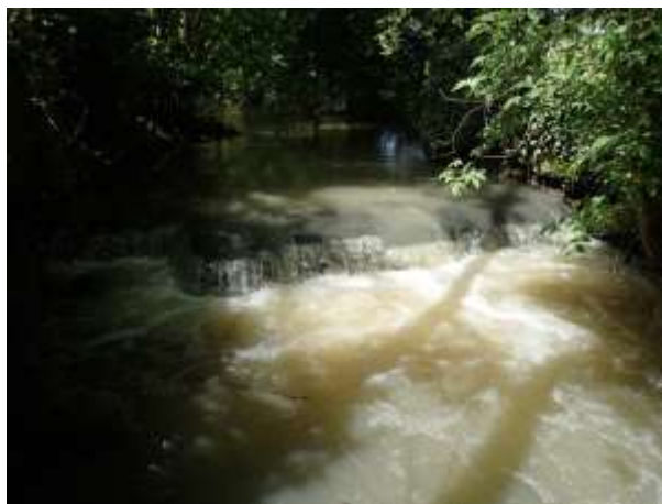
Figure 27 : Photographie du seuil entre les profils en travers 76 et 77 Source : GRAINEau et SIGosphère
