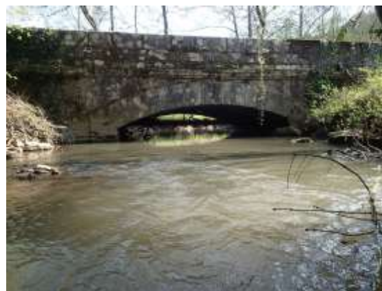
Figure 45 : Ouvrage de franchissement au droit du profil en travers 66
