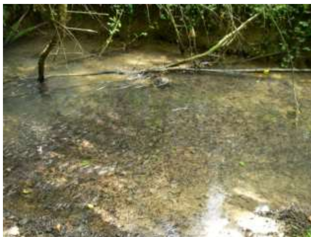
Photo 3 : Radier sur la station AVR (source : ARALEP)
