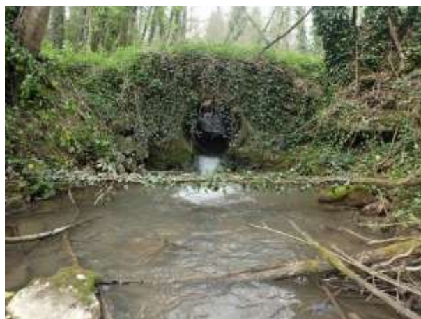
Figure 91 : Photographie du busage de 1 000 mm de diamètre en amont du profil en travers 16 Source : SIGosphere
