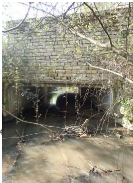
Figure 90 : Coupe transversale et photographie du dalot du bief au droit du profil en travers 14 Source : SIGosphere
