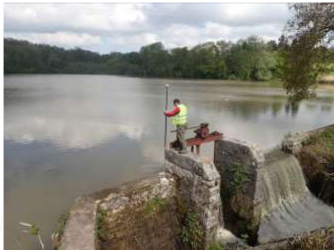
Figure 31 : Coupe et photographie de l'ouvrage hydraulique (déversoir et vannage) de l'étang du moulin de Buthiers Source : SIGosphere et GRAINEau
