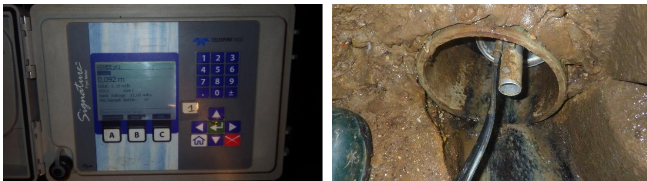
Figure 14 : Appareillage utilisé - inspection nocturne
