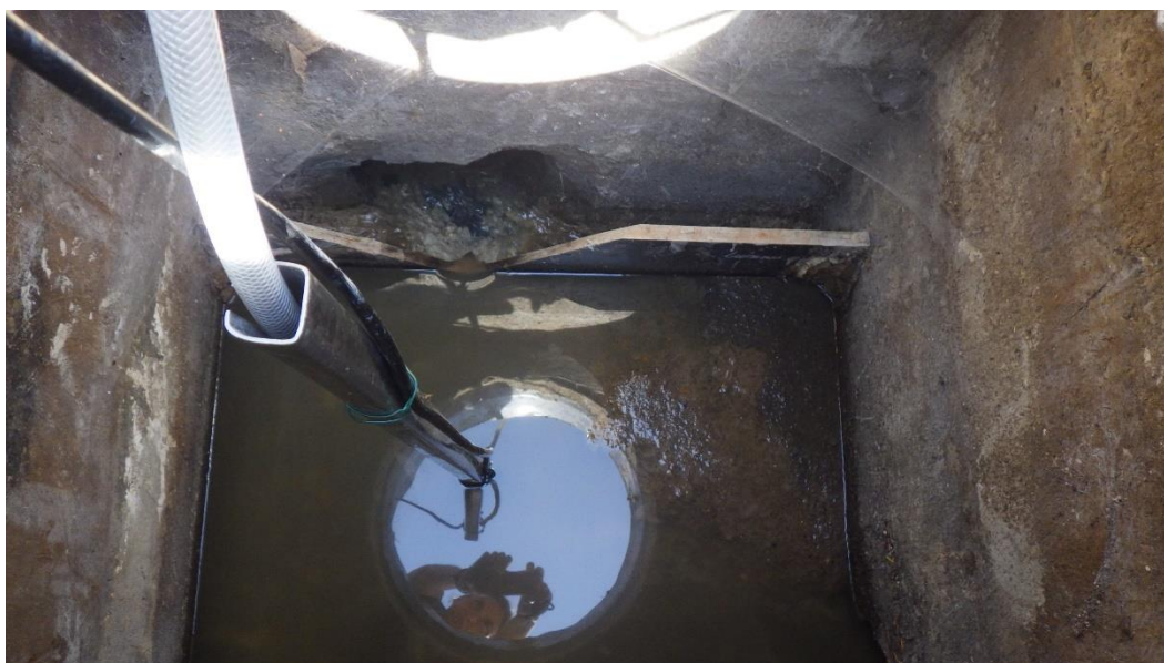
Figure 7 : Mesure de débit en entrée de STEU
