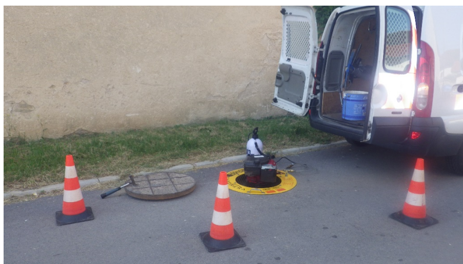
Figure 24 : Générateur de fumée en fonctionnement
