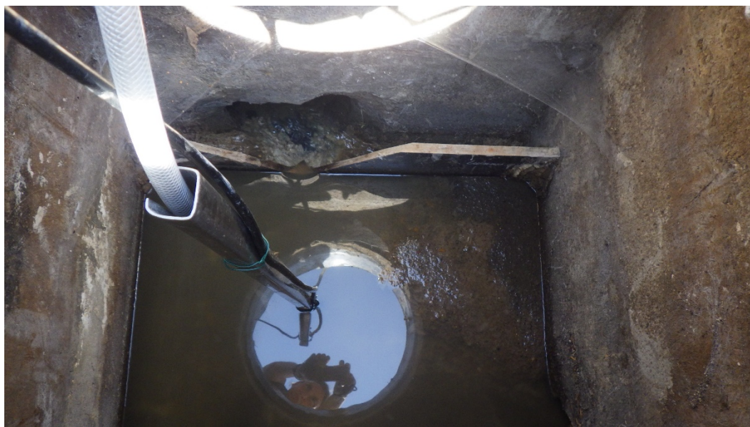
Figure 14 : Mesure de débit en entrée de STEU
