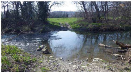
Exemple de passage à gué noyé en enrochement percolé sur la lône Dion
