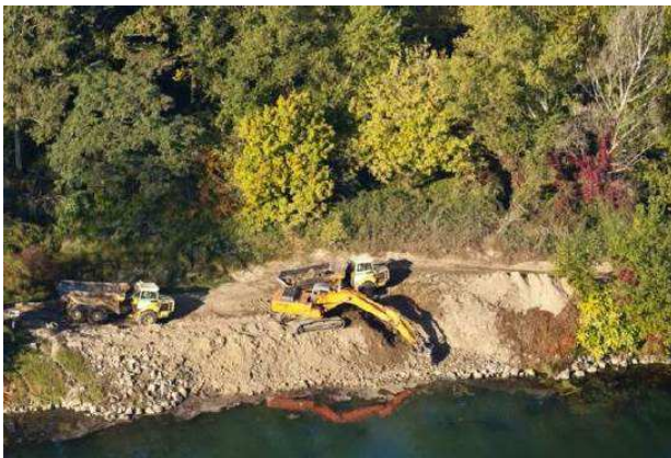
Degré 2 - démantèlement partiel des ouvrages Girardon - Casiers de Cornas (vieux Rhône Bourg les Valence)
