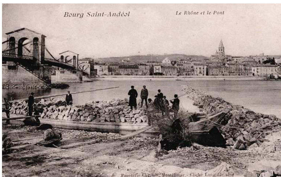
Carte postale de Bourg Saint Andéol (début XXème siècle) illustrant la mise en œuvre des ouvrages Girardon.
