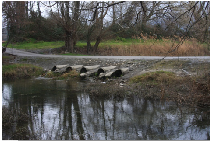
Ouvrage de franchissement actuel H
