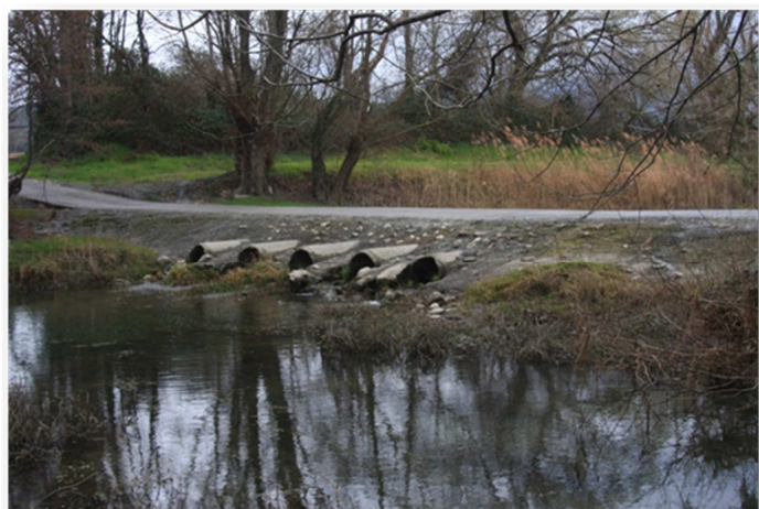
Figure 38 : Ouvrage de franchissement busé (H).
