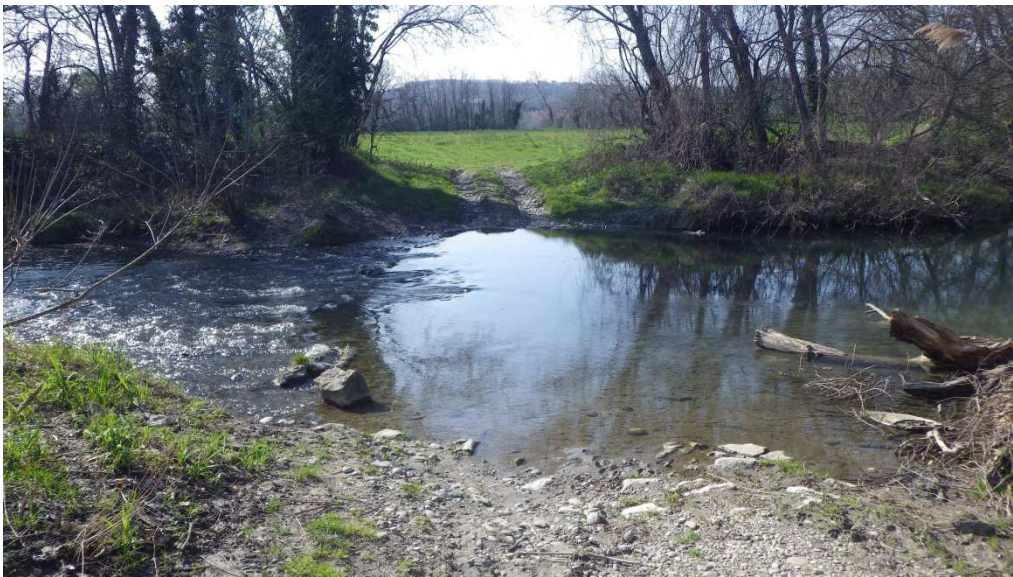
Figure 49 : Exemple de passage à gué noyé en enrochement percolé sur la lône Dion
