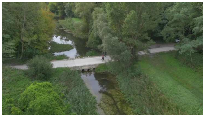
7/ Passage à gué principal.
