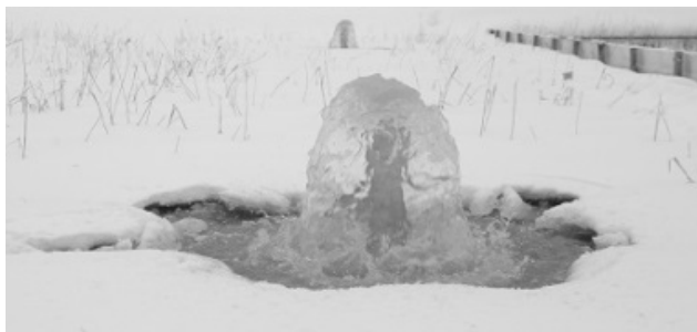
Figure 7 : 1ère bâchée d'alimentation d'un filtre enneigé (St Just Malmont, février 2013, photo C. Tscherter)
