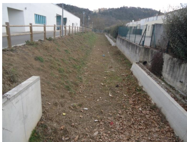
Figure 23 : Bassin de rétention proche Gymnase
