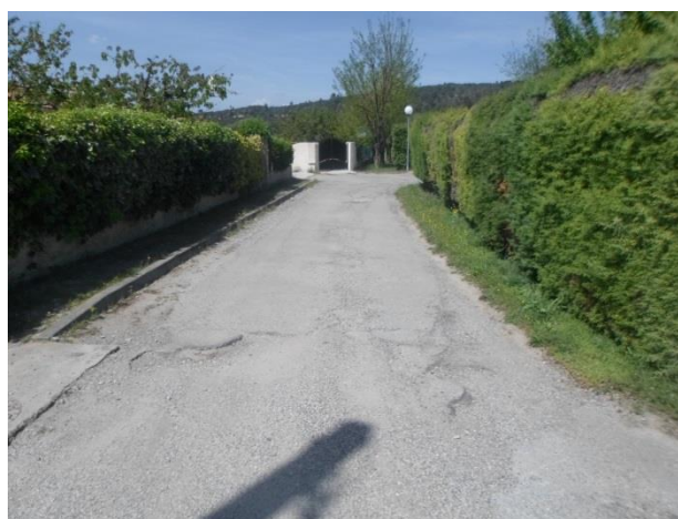
Figure 25 : "Exutoire" du réseau des eaux pluviales
