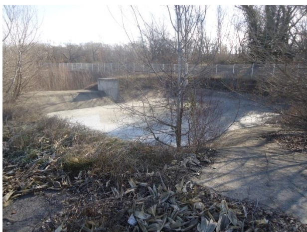
Figure 22 : Bassin de rétention ZAC Pas de Menc
