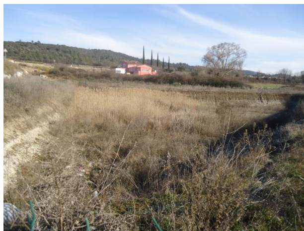
Figure 21 : Bassin de rétention route de Manosque
