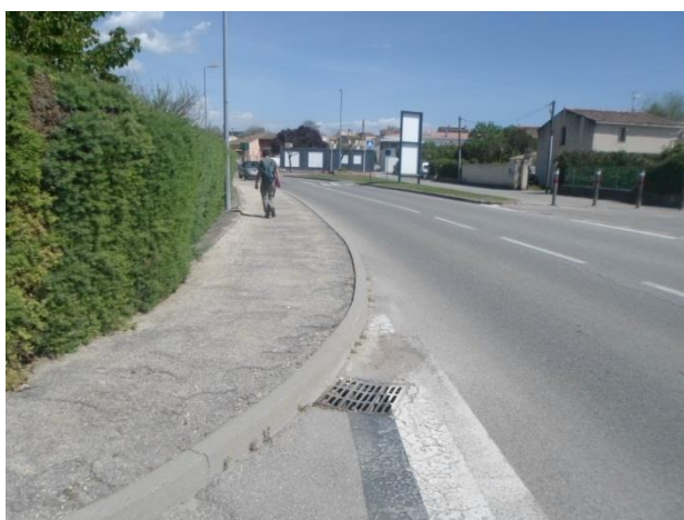
Figure 24 : Avaloir servant d'exutoire au réseau
