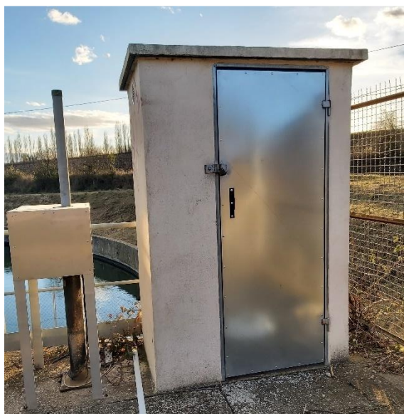
Figure 3-5 : Principe de bâti pour armoire de contrôle-commande
