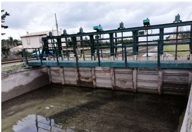
Ouvrage en ligne
