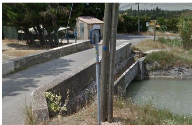
Figure 3-6 : Implantation sonde amont Valloncourt
