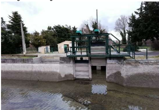
Ouvrage de décharge
