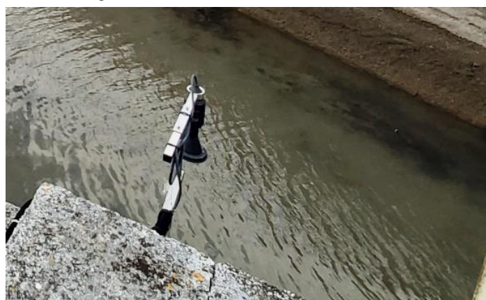
Figure 3-4 : Sonde de niveau amont Bel Hoste
