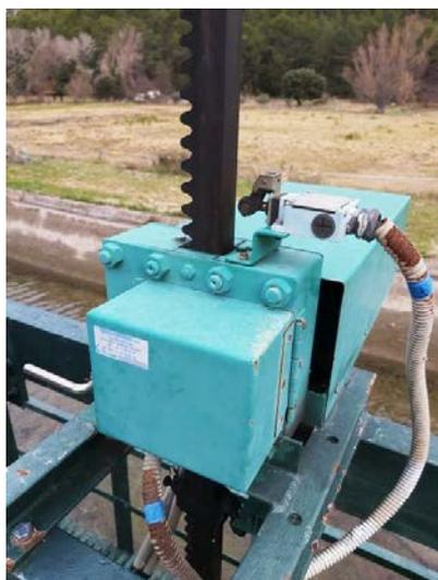
Figure 4-14 : Capteurs de fin de course des vannes plates à crémaillère
