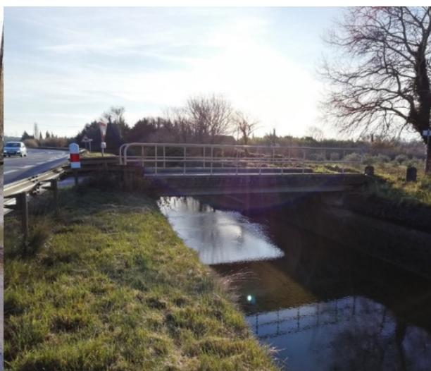
Pont-dalle sans pile centrale dont le tablier repose sous la berge du canal (OF-3761) – Bon état
