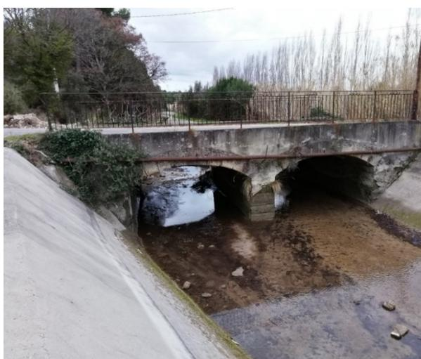
Pont en maçonnerie avec pile centrale (OF-8441) – État moyen
