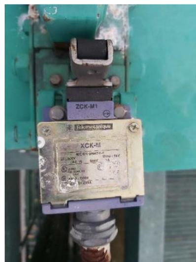
Ce matériel n'appelle pas de dysfonctionnement particulier au dire de l'Exploitant. Toutefois, nous notons que l'étanchéité n'est pas assurée au niveau de la gaine de protection du câble.
