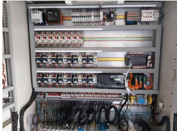
L'API et le S550 ont été remplacés en 2019 dans le cadre de travaux de modernisation. La communication entre ces deux équipements est de type Ethernet. Le S550 communique avec l'extérieur via le réseau RTC.
