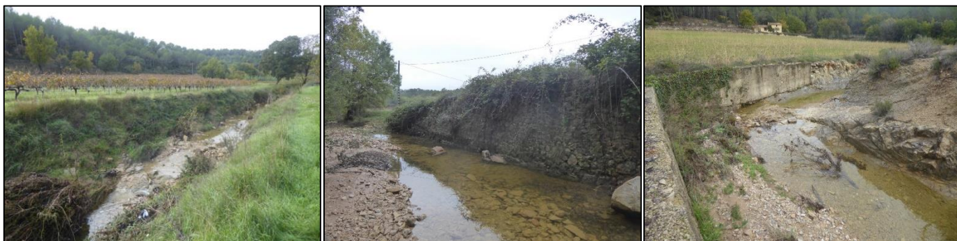
Chenalisation dans la traversée du domaine de Caseneuve (à gauche), exemples de protections de berge en amont du village (au centre, à droite)
