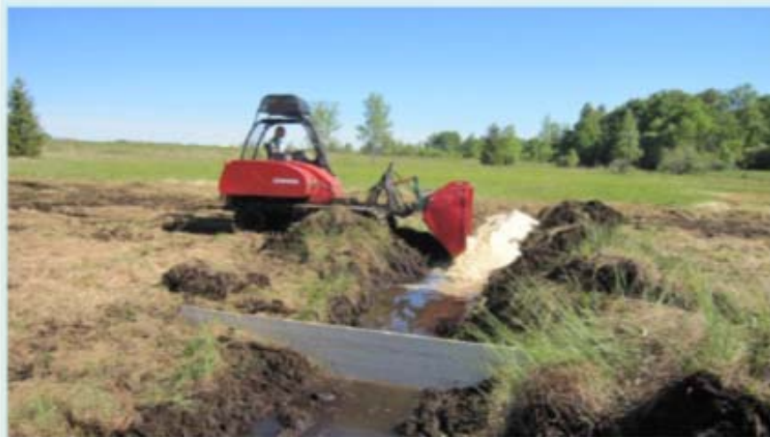
3- Comblement à la sciure et compactage
