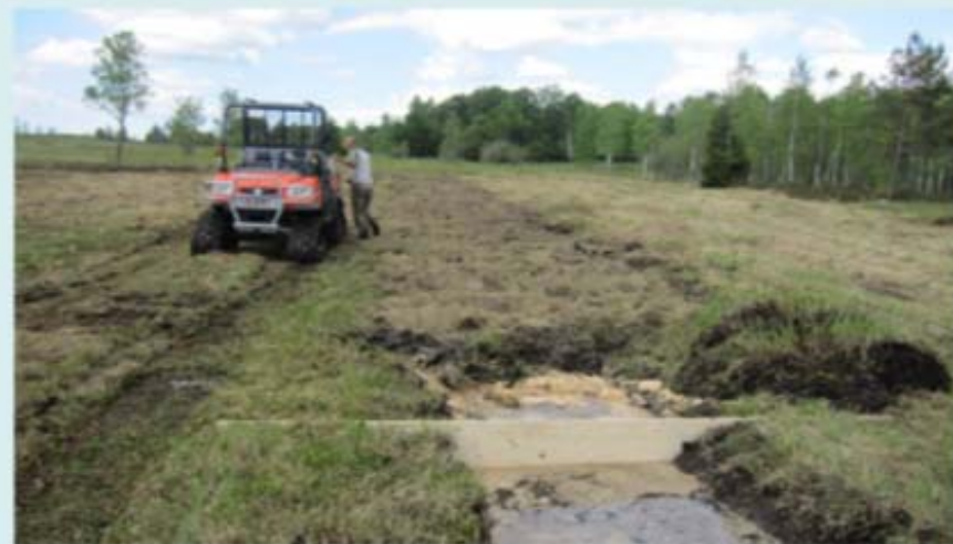
4- Recouvrement par de la tourbe et paillage pour éviter le dessèchement
