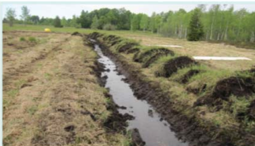
1- curage du fossé : « fond propre, bords propres » pour garantir ensuite une bonne cohésion de la sciure sur la tourbe et stockage de tourbe sur les bords.
