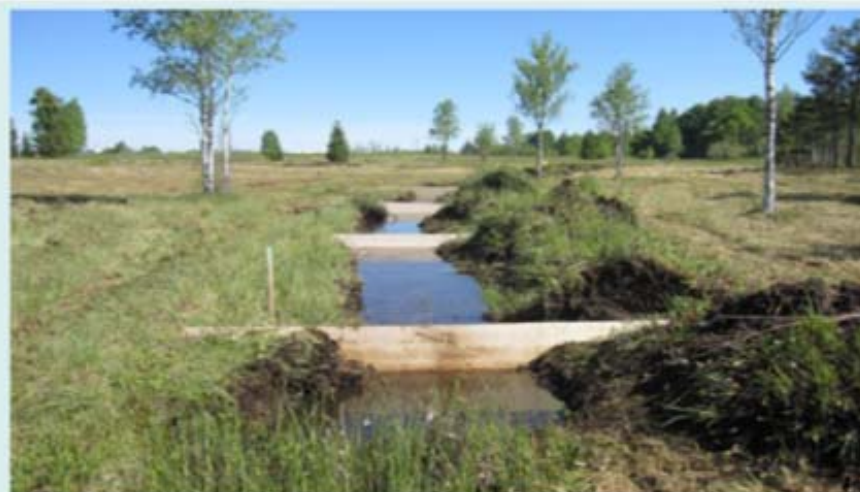
2- installation des panneaux de bois (4X1m) pour assurer des « points durs » de blocage de l'eau
