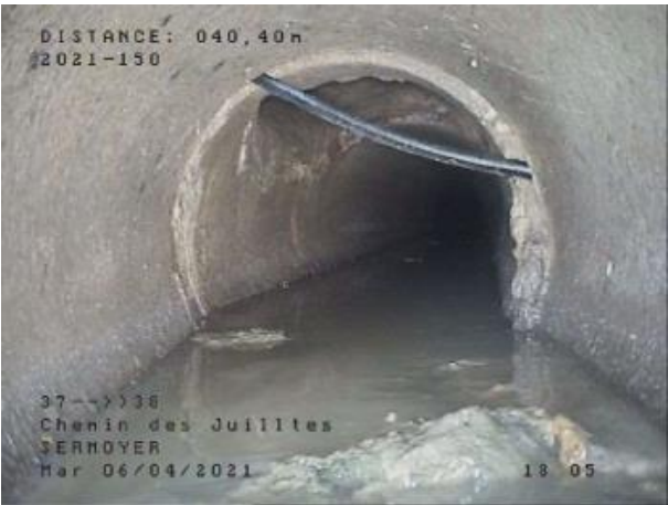
Joints pénétrants – Chemin des Juillets
