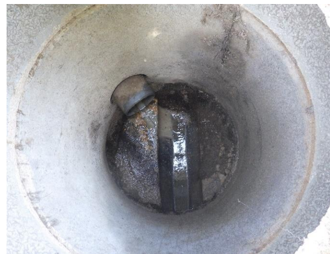
Enracinement total de la conduite - Regard 166 – Chemin du moulin
