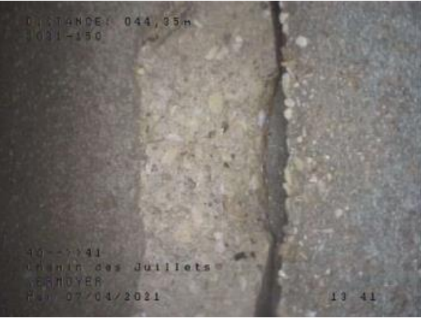
Paroi manquante – Chemin des Juillets
