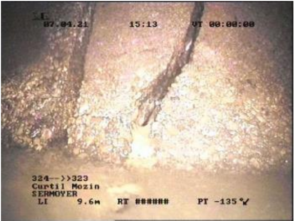
Fissure ouverte – Curtil Mozin
