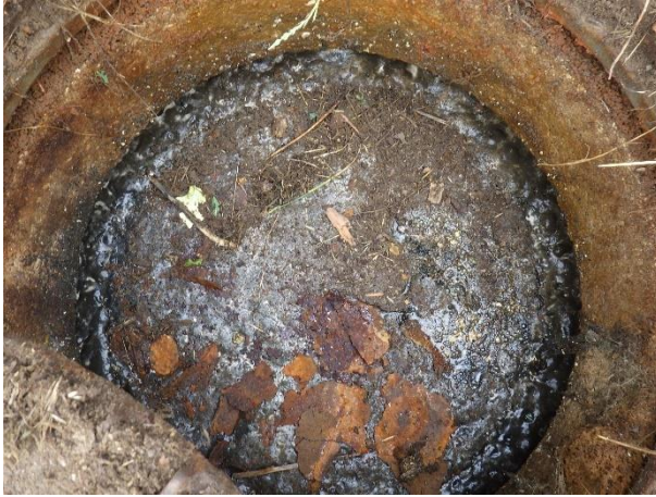
Dépôts – Regard 762 – Rue de la Vieille Seille
