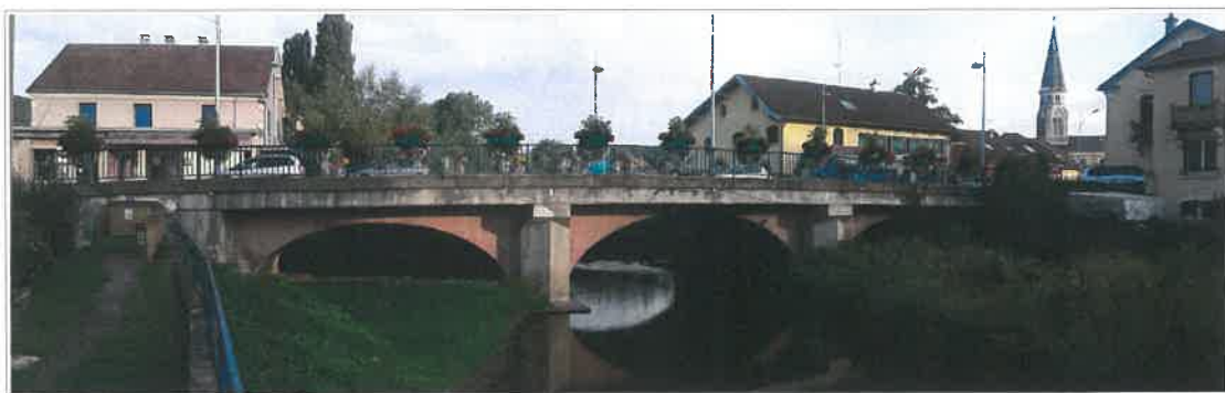
Vue du pont Carnot
