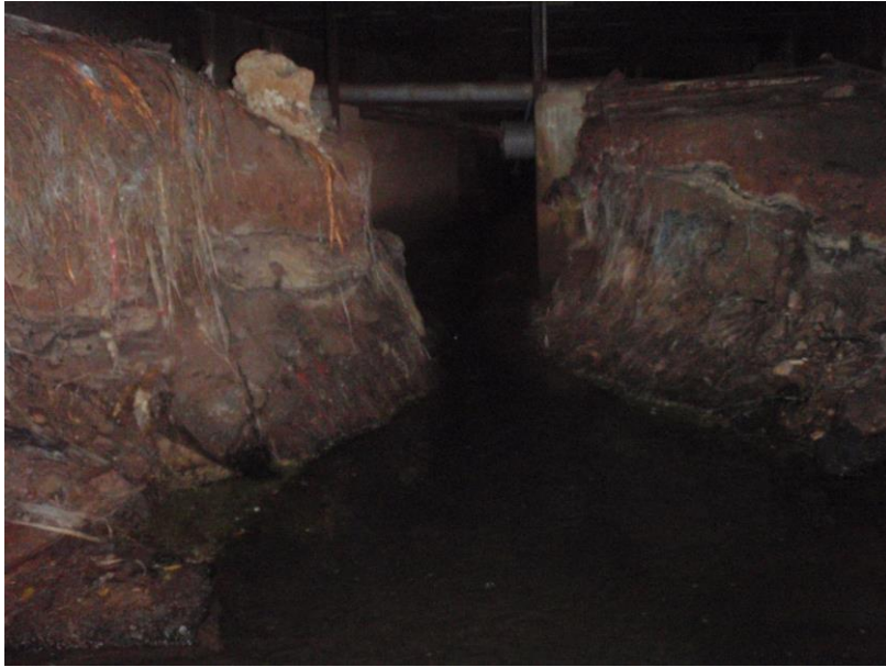
Figure 49 : Exutoire du bras de décharge
