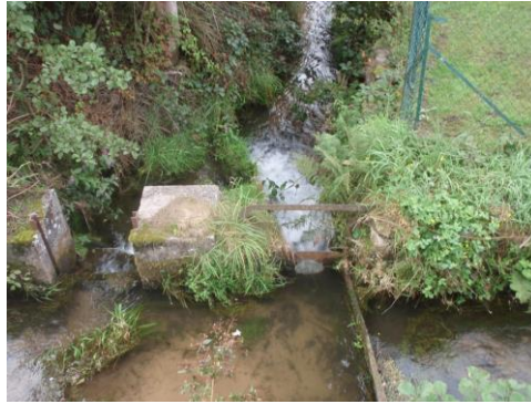
Figure 46 : Ancien vannage de décharge
