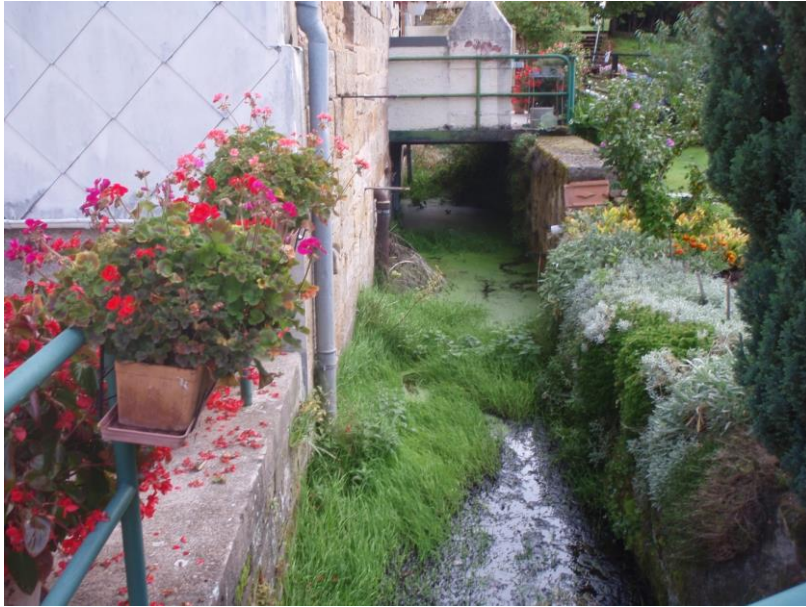
Figure 44 : Canal de dérivation
