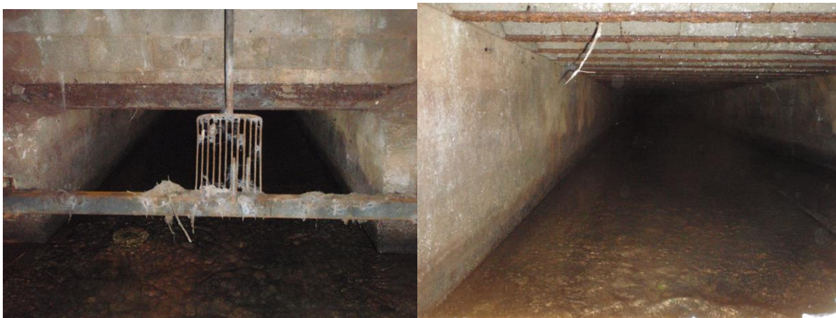
Figure 48 : Exutoire du canal de dérivation
