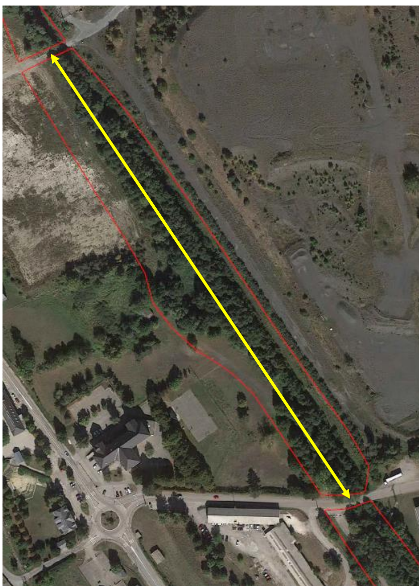
Figure 8 : Tronçon du pont d'accès au parc solaire au pont de la Fange
