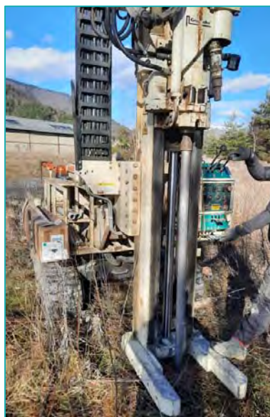
Figure 3 : Photographie de la réalisation d'un sondage au carottier sous gaine
