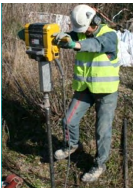
Figure 2 : Photographie de la réalisation d'un sondage au carottier portatif
