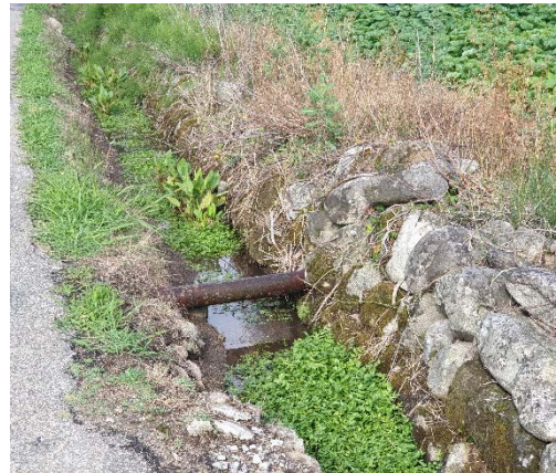
Fossé annexe du ruisseau de Chamandre
