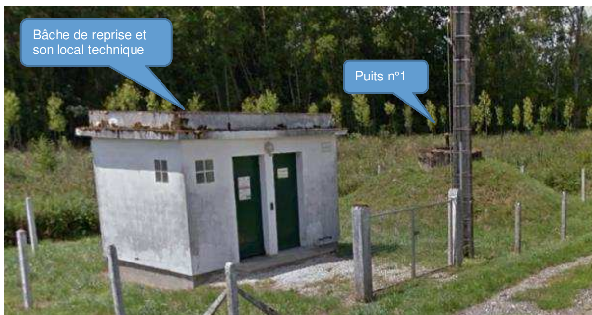
Figure 32 : Environnement de l'unité de pompage
