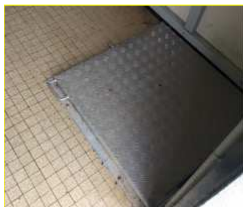
Accès à la fontainerie
