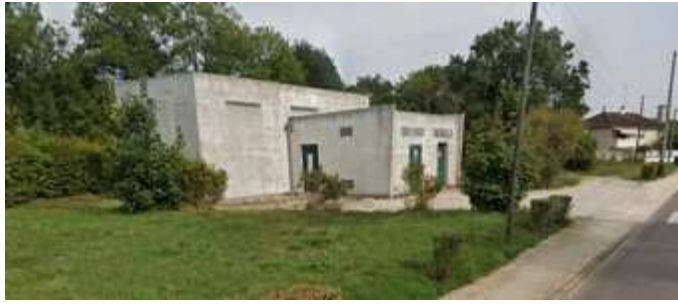
Bâtiment en dur
